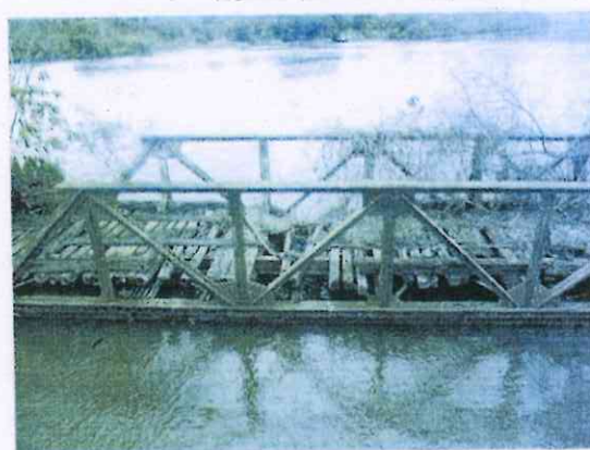
Figura 10 – Estrutura de uma das bases de apoio.
