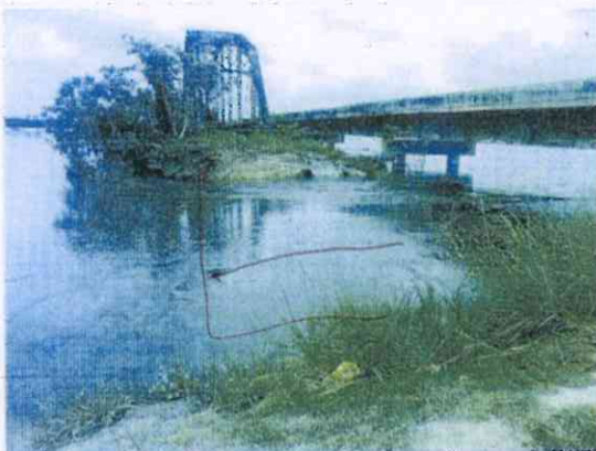
Figura 01 – Vista geral da ponte. É visível o canal construído para passagem dos barcos quando o nível do rio aumenta.
