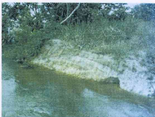
Figura 14 – Lateral do canal com as marcas da escavação realizada e sem estrutura.
