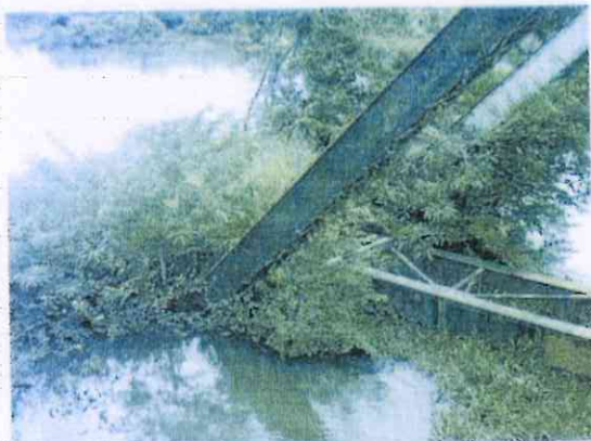
Figura 05 – Apoio da ponte.
