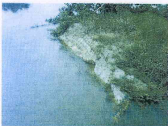
Figura 13 – Lateral do canal mostrando sinais, apenas, de escavação. Esta lateral serve de suporte para a ponte metálica.
