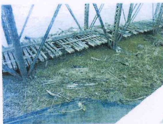
Figura 07 – Estrutura central da ponte.
