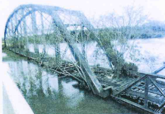
Figura 08 – Vista lateral da ponte.
