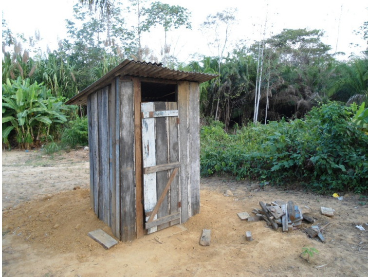
Foto 6-57 – Estrutura dos sanitários
