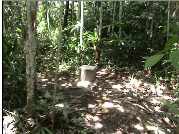
Figura 3.6-1. Piezômetro instalado na entrada da parcela 4.000m-T1 do módulo de Teotônio.
