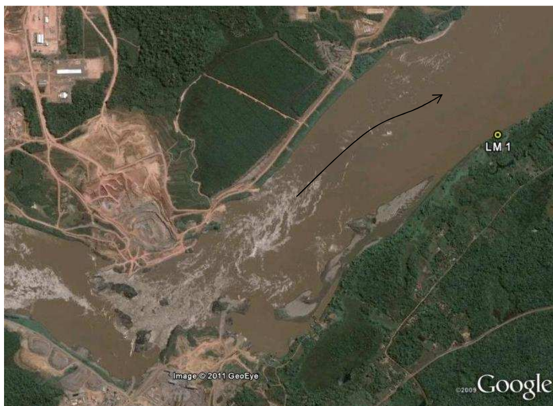
Figura 3.2. Vista em Planta do Rio Madeira no Local de Monitoramento 1
