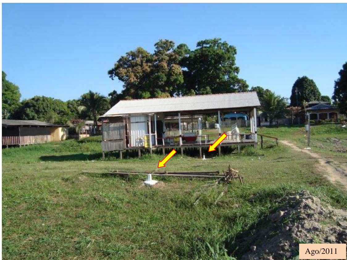
Figura 3.32. Instalação dos Marcos de Referência no Local de Monitoramento 8
