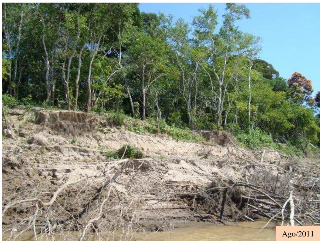
Figura 3.22. Vista da Margem do LM-6 no Período de Águas Baixas do Rio Madeira
