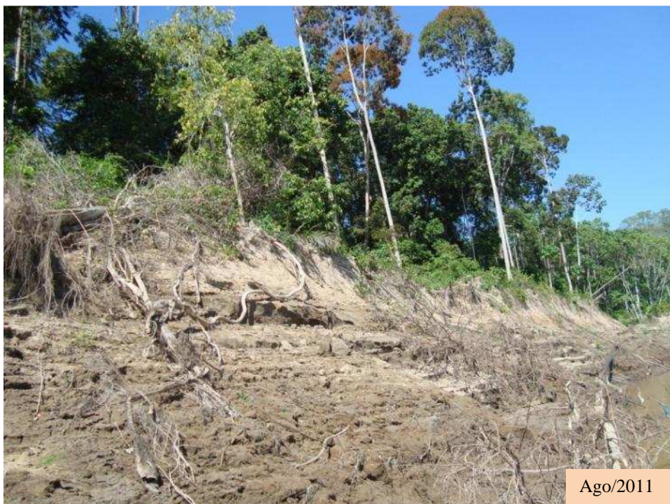
Figura 3.28. Vista Geral da Margem do LM-7 em Agosto/2011
