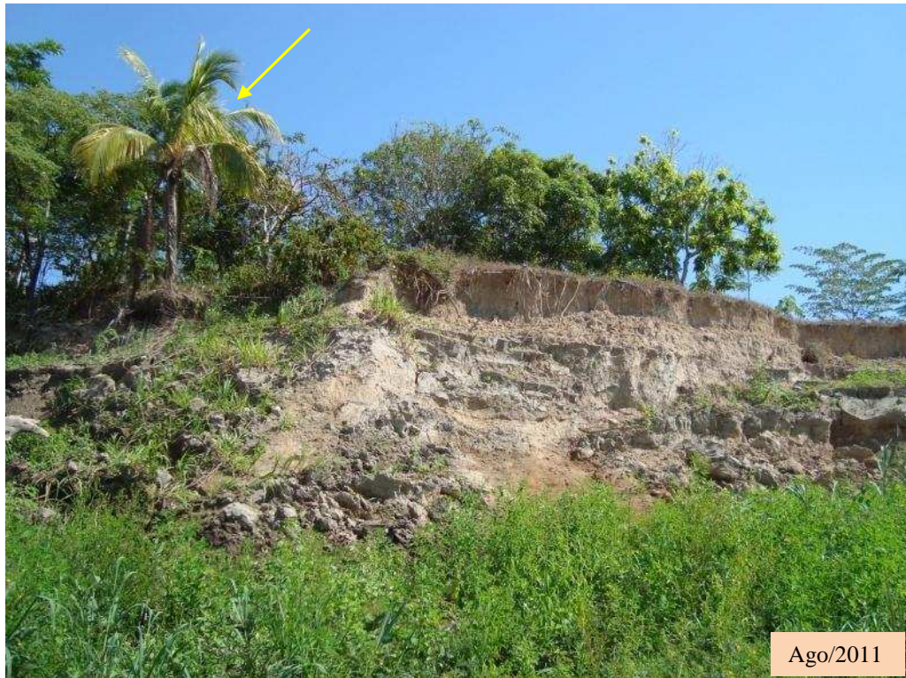
Figura 3.12. Vista Geral da Margem no Local de Monitoramento 3 em Agosto de 2011
