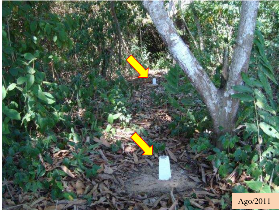
Figura 3.5. Instalação do Conjunto de Marcos de Referência para Estabelecer o Alinhamento do Perfil Topográfico do Local de Monitoramento 1
