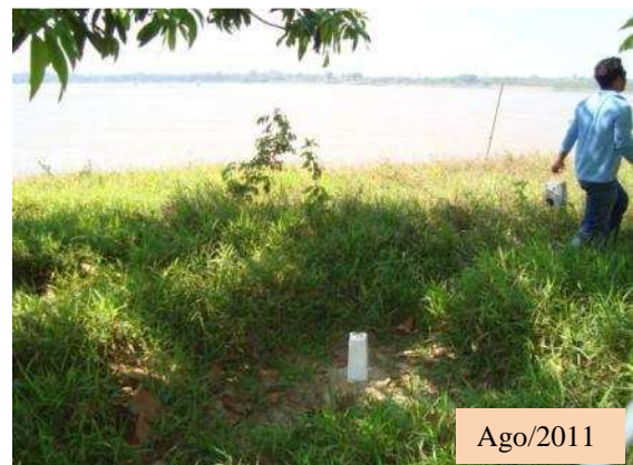
Figura 3.13. Implantação do Piquete e do Marco de Referência no Local de Monitoramento 3
