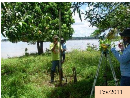
Figura 3.13. Implantação do Piquete e do Marco de Referência no Local de Monitoramento 3
