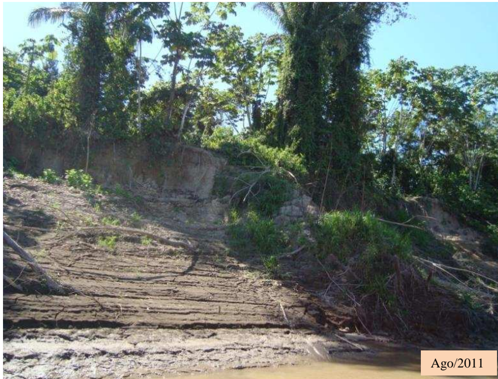
Figura 3.72. Vista da Linha de Margem no Local de Monitoramento 17
