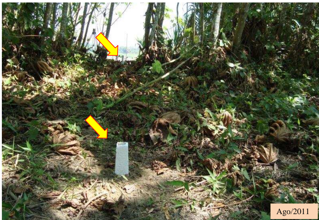
Figura 3.9. Instalação do Conjunto de Marcos de Referência no LM-2
