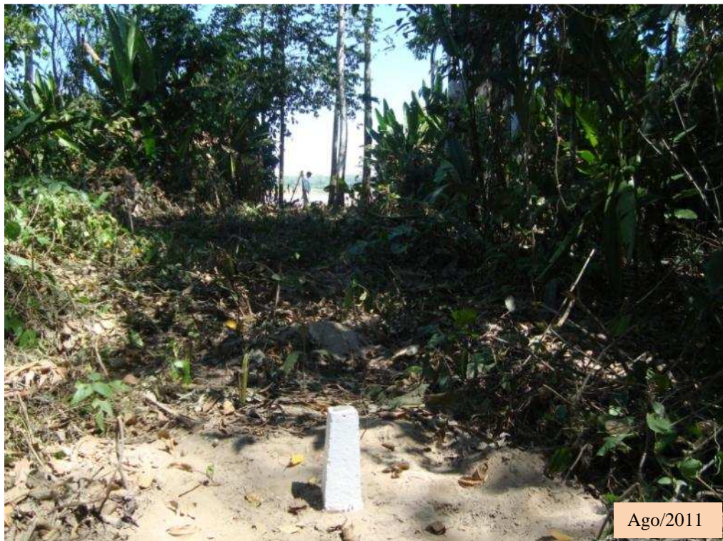
Figura 3.63. Alinhamento dos Marcos de Referência no Local de Monitoramento 15
