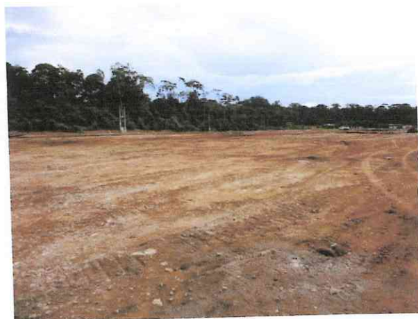
Remoção do material gerado na demolição do piso de concreto e aplicação nos aterros para elevação dos acessos
