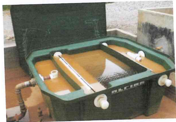
Remoção do óleo retido nas caixas separadoras de água e óleo e posterior remoção das caixas.
