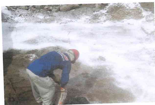
Remoção das caixas coletoras de esgoto sanitário seguindo as seguintes etapas: ✓ coleta do material contido nas caixas com uso de caminhão limpa fossa; ✓ remoção da caixa coletora de esgotos; ✓ desinfecção do terreno com uso de cal.
