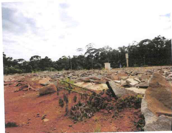
Aspecto final do piso de concreto das centrais de carpintaria, armação e pré-moldados após operação do "picão"
