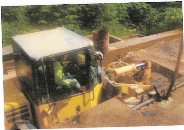
Limpeza da caixa de decantação de sólidos do sistema separador de água e óleo da rampa de lavagem e lubrificação.
