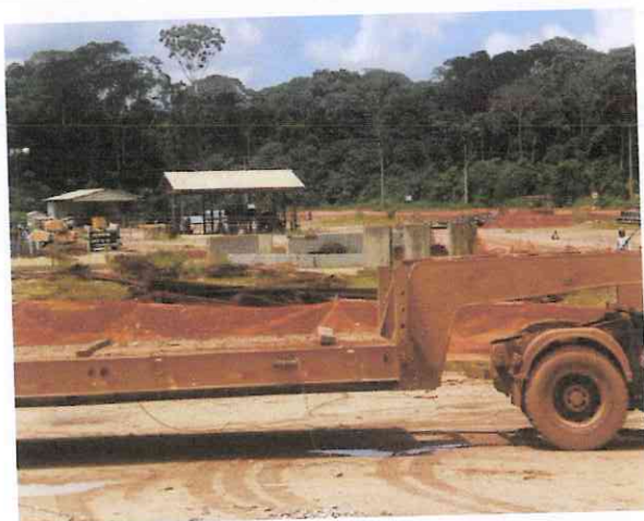
Desmonte e remoção das edificações e material estocado no pátio: pré-moldados, sucata ferrosa, madeira.
