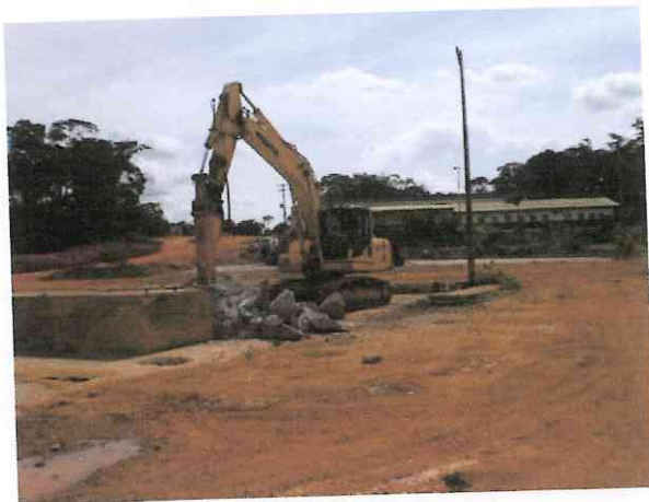
Uso do "picão" para demolição do piso de concreto armado. Abertura de poços de monitoramento para avaliação de indícios de contaminação do solo por produtos oleosos (relatório de análise em anexo).
