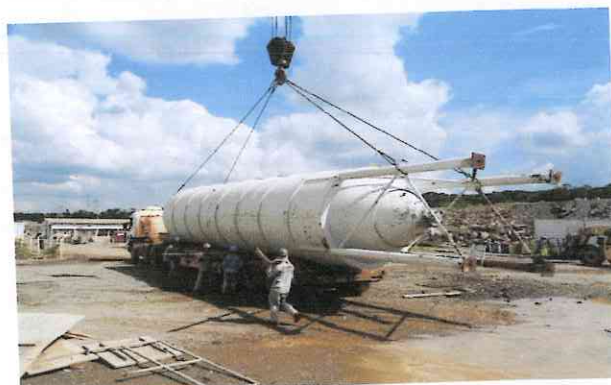
Desmontagem e remoção das estruturas e equipamentos das centrais de concreto, britagem e escritórios
