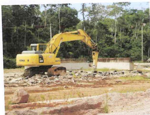
Demolição do piso de concreto armado com uso do "picão"
