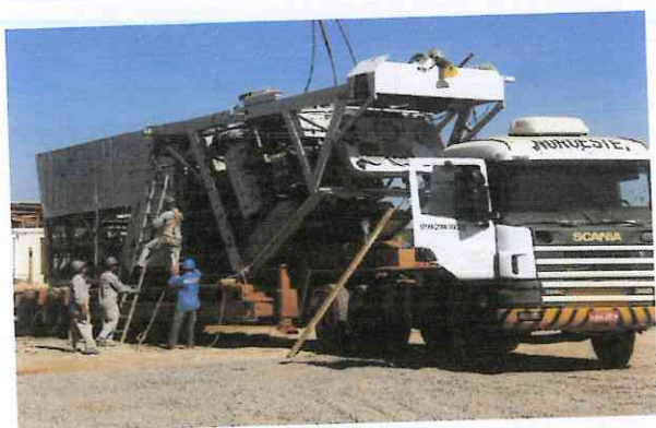
Desmontagem e remoção das estruturas e equipamentos das centrais de concreto, britagem e escritórios
