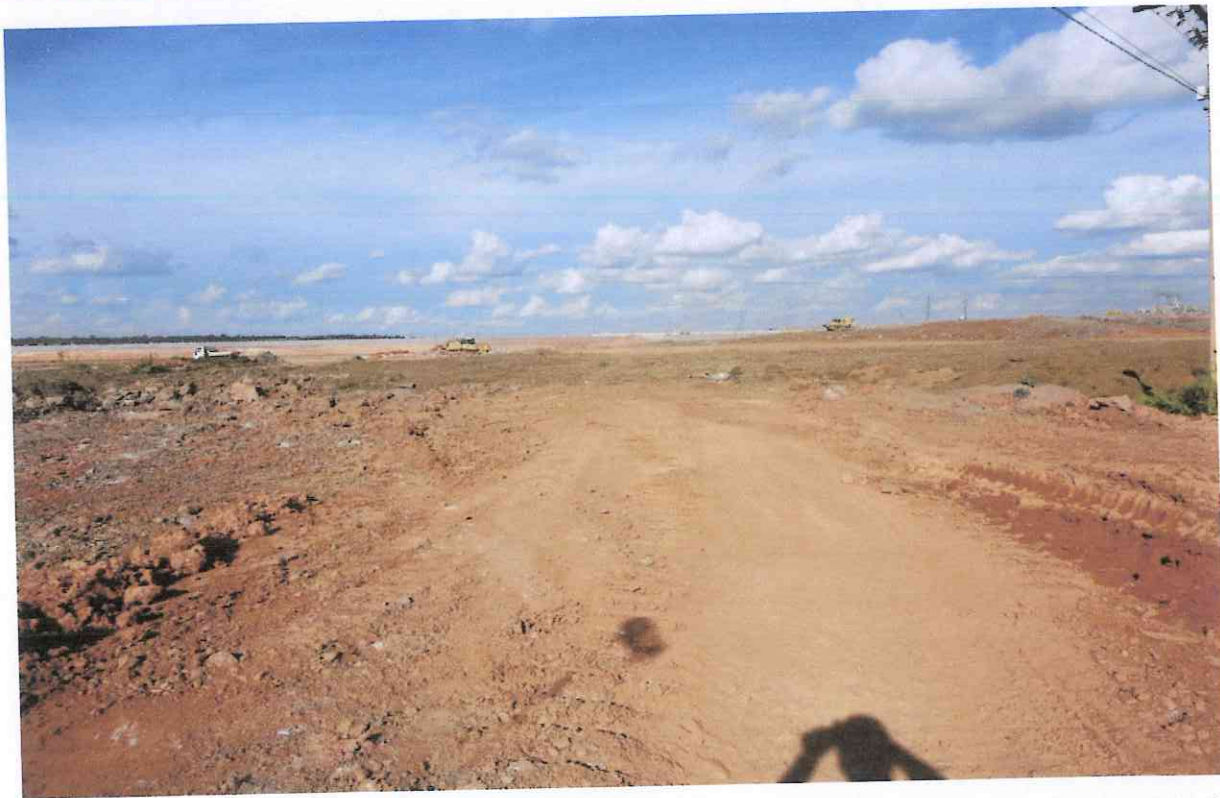
Aspecto final das áreas desmobilizadas do canteiro MD, localizadas na cota de alagamento do reservatório, depois de removidas estruturas e realizado o reafeiçoamento do terreno
