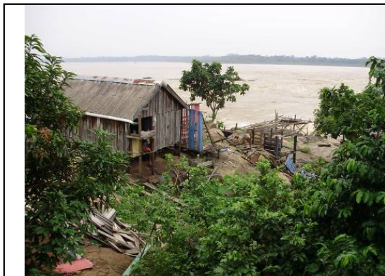
Foto 55 – 26/11/2009 – Vila Amazonas. Vista geral e algumas casas já demolidas.
