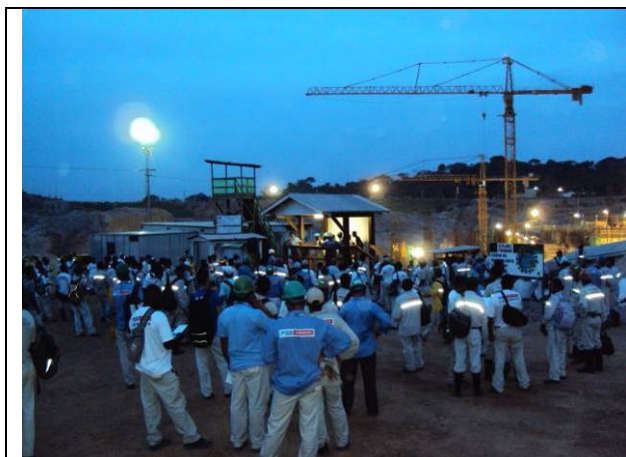
Foto 6 – 06/11/2009 – TDS realizado no estacionamento da Casa de Força (concretagem), margem direita, turno noturno.
