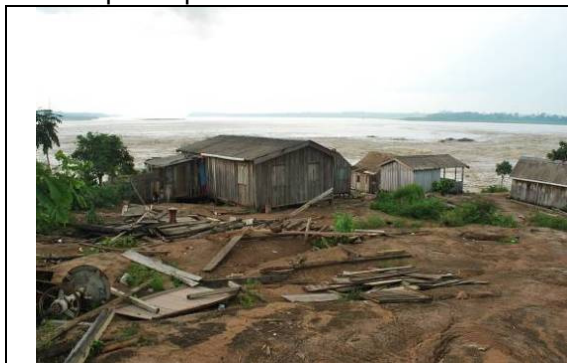
Foto 53 – 28/11/2009 – Vila Amazonas, casas já desocupadas.
