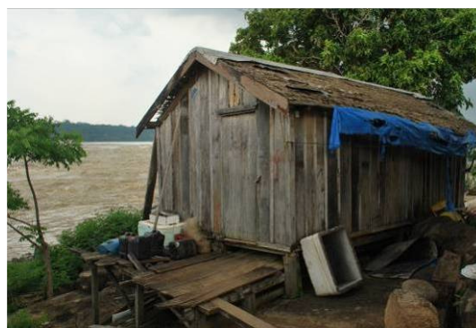
Foto 56 – 28/11/2009 – residência do Sr. Aníbal fechada desde o dia 26/11/2009.
