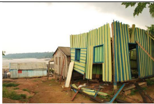
Foto 54 – 28/11/2009 – Vila Amazonas, residência sendo desmontada/removida.
