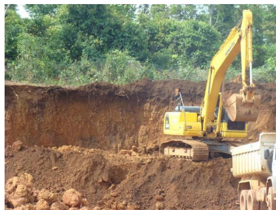
Figura 10. Jazida de Cascalho "7". Notar espessura de solo semelhante à Terra Preta Indígena (TPI) nos primeiros 50cm de profundidade. Ausência de material arqueológico.
