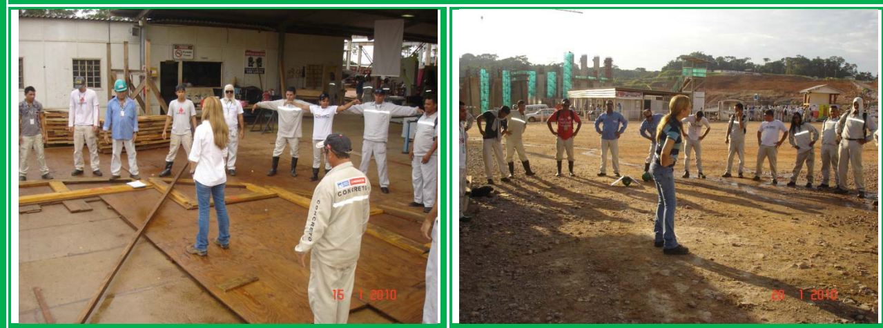
TDS realizado em diversos setores do canteiro de obras.
