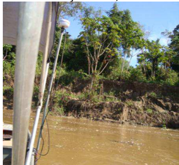
Figura 3.51. Processo de Erosão de Margens na Seção ST 76,3
