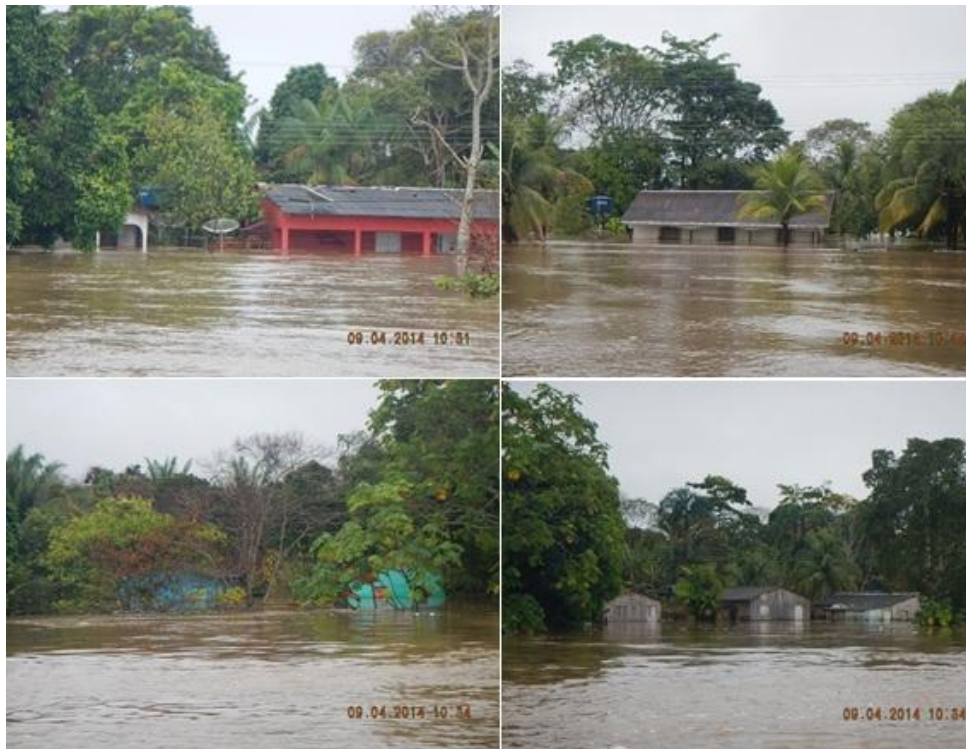
Figura 2. Casas do distrito de São Carlos inundadas pelas águas do Rio Madeira em abril de 2014.
