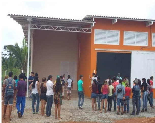
Figura 18: Comunidade recebendo estrutura física da Agroindústria de Cujubim.
