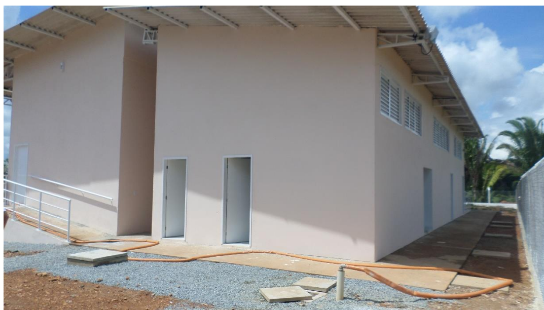
Foto 03 - Elevação geral da obra;
