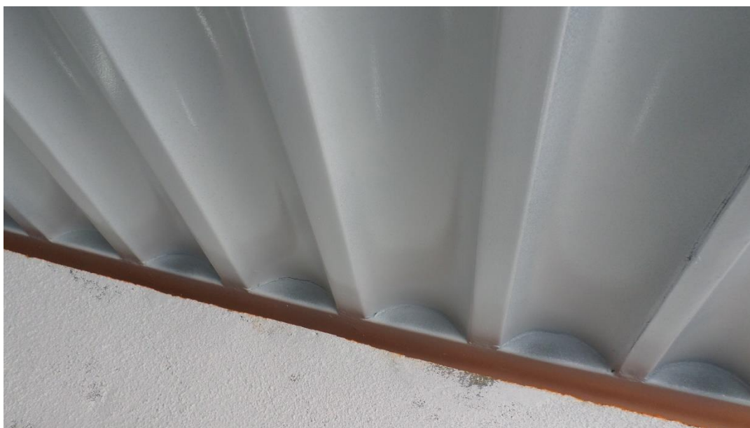
Foto 14 - Pintura das portas metálicas;
