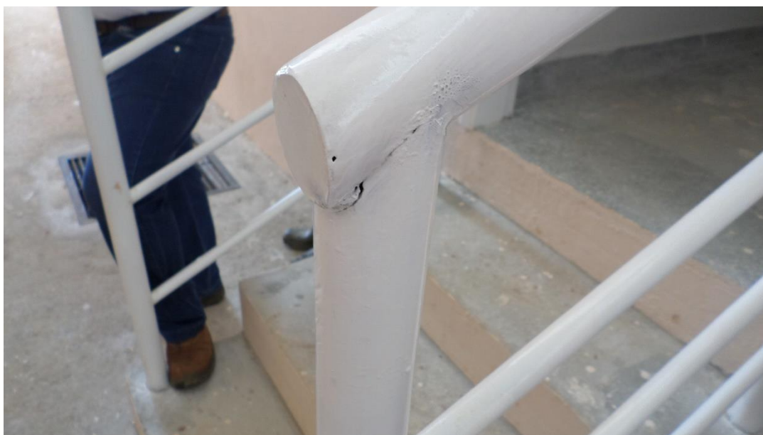
Foto 08 - Acabamento do corrimão e guarda corpo;
