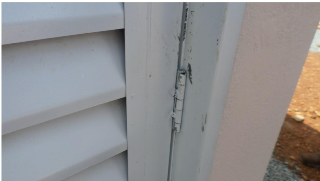
Foto 11 - Pintura / acabamento das portas metálicas;
