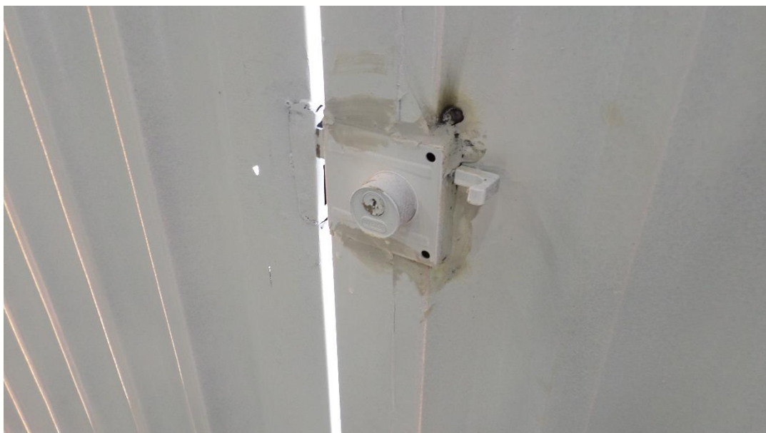
Foto 13 - Pintura das portas metálicas;
