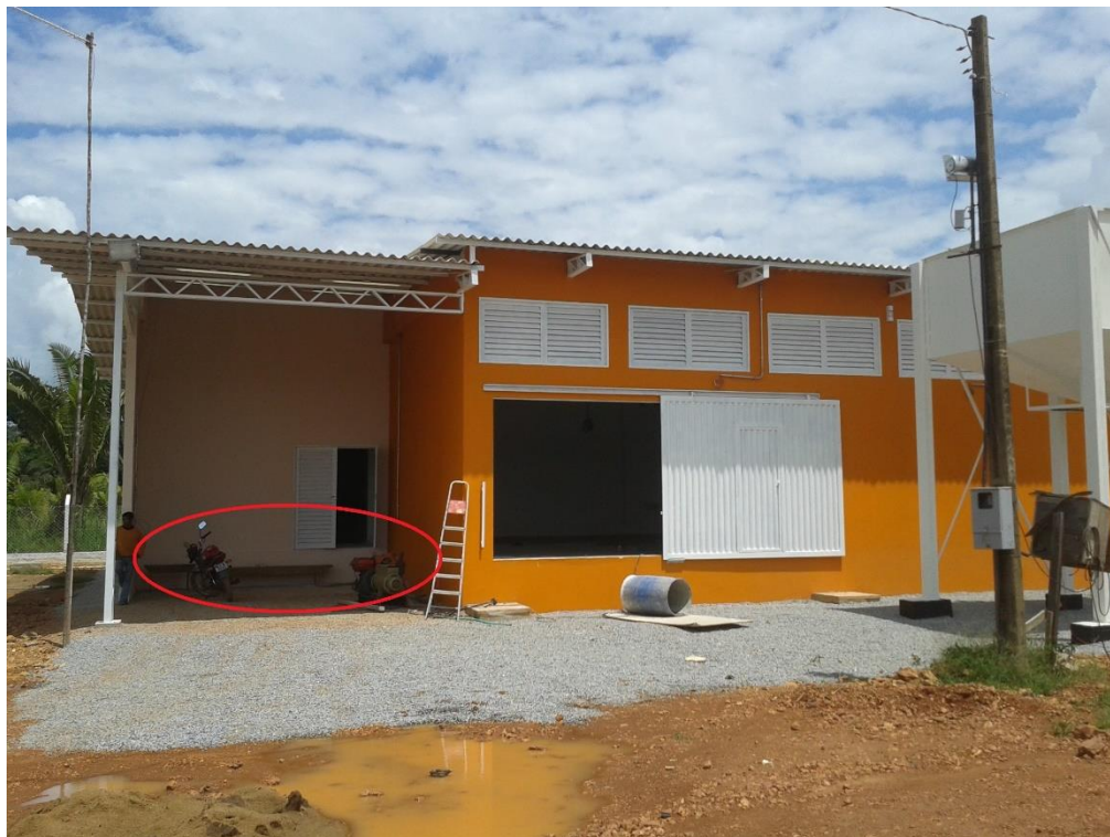
Foto 30 - Doca de carga e descarga.
