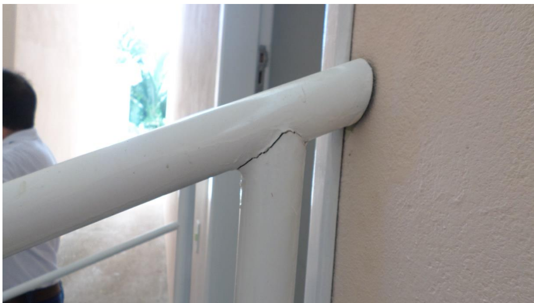
Foto 09 - Acabamento do corrimão e guarda corpo;
