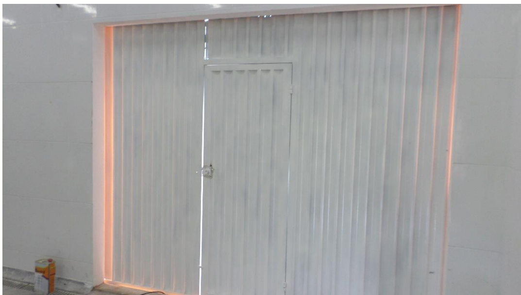
Foto 12 - Pintura das portas metálicas;
