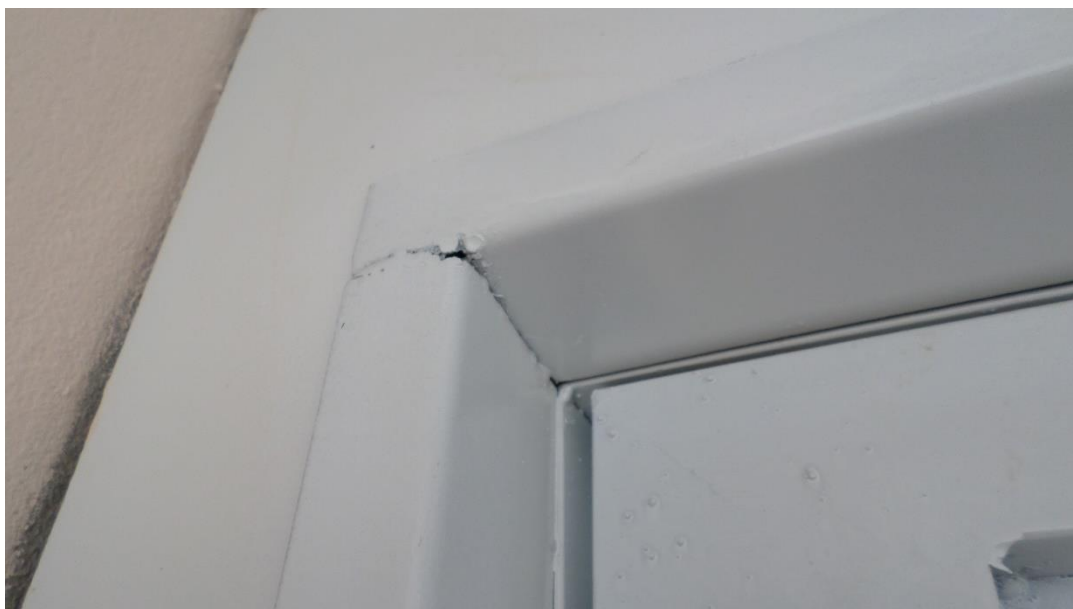
Foto 10 - Pintura / acabamento das portas metálicas;
