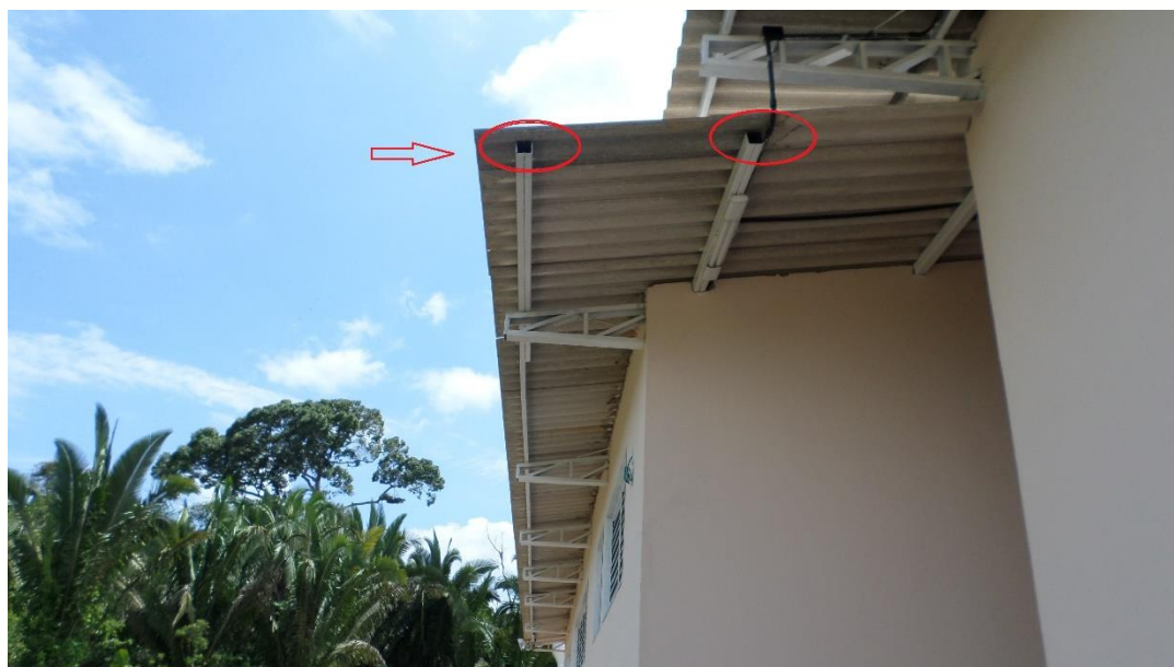
Foto 17 - Estrutura metálica da cobertura;
