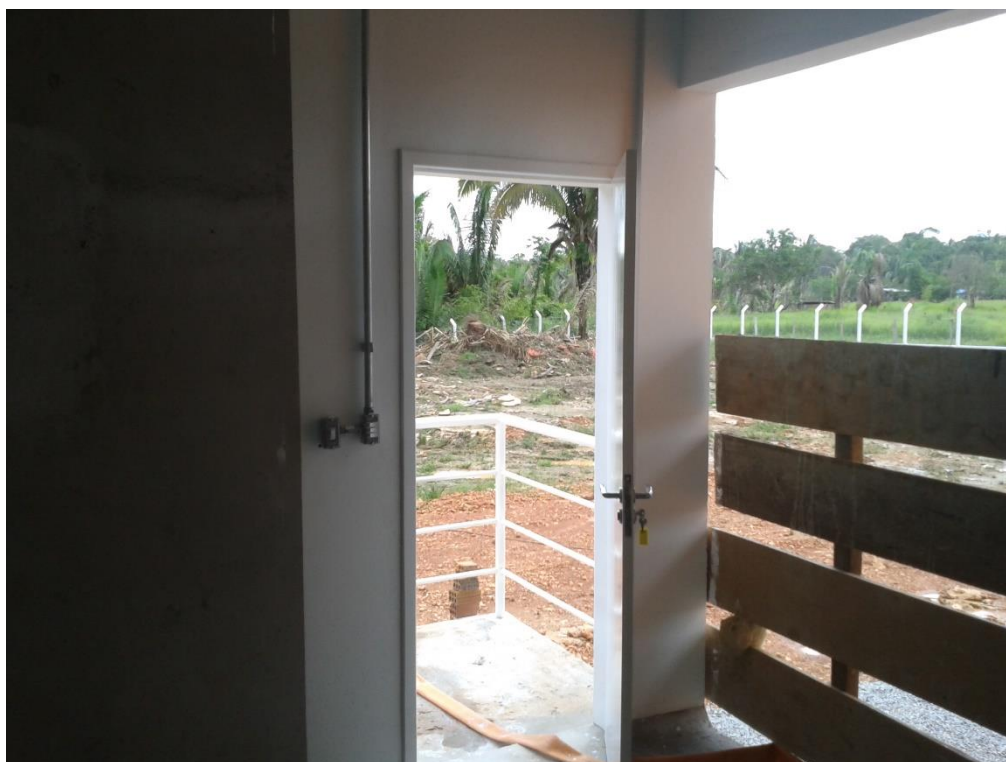
Foto 16 - Porta madeira / metálica;
