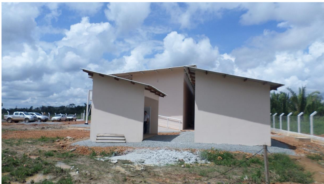
Foto 04 - Elevação geral da obra;
