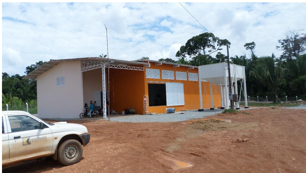
Foto 01 - Elevação geral da obra;
