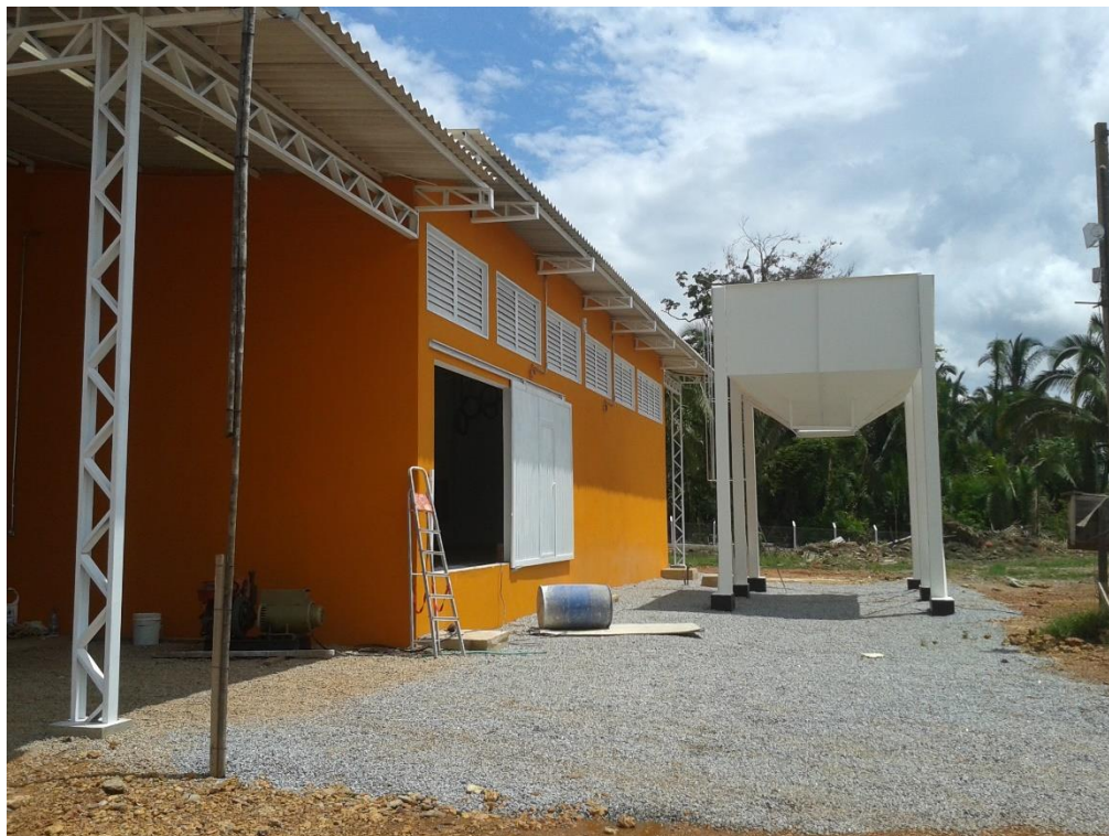
Foto 02 - Elevação geral da obra;
