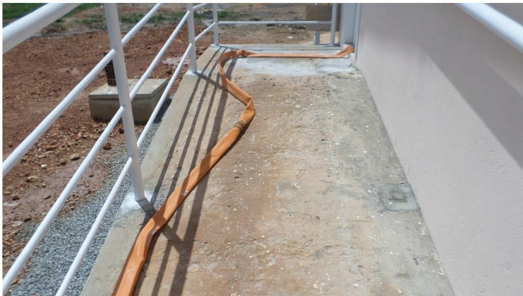
Foto 26 - Piso em concreto
