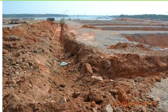
Detalhe de valeta escavada para drenagem da água da chuva
