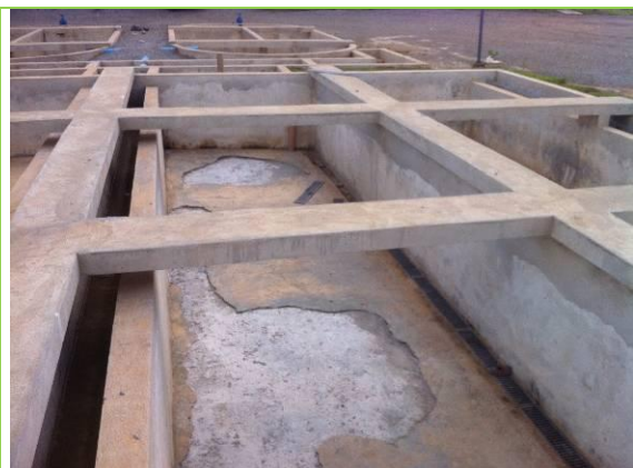
Escarificação do fundo dos raceways
