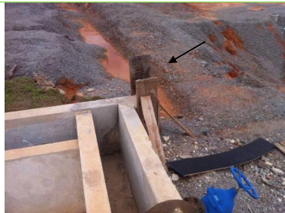
Construção de colunas de sustentação nos raceways.
