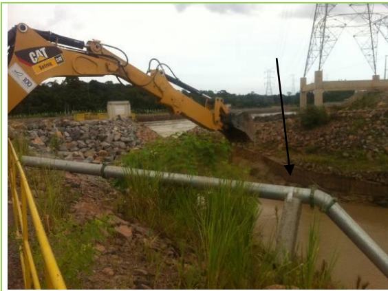
Reparo da adutora de abastecimento da torre de água devido deslocamento do pilar e ruptura da solda
