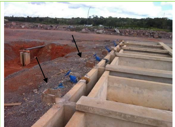
Construção de colunas de sustentação nos raceways.
