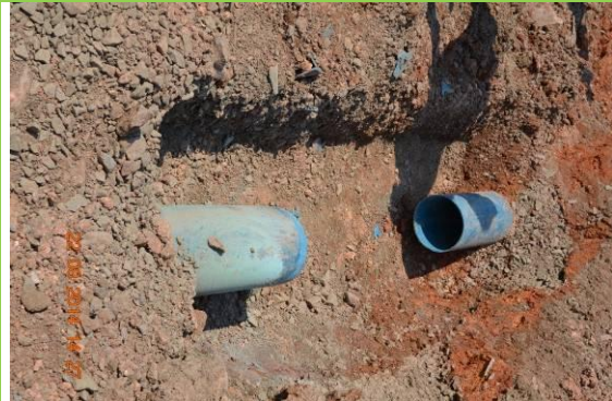
Detalhe de cano da adutora sendo consertada .
