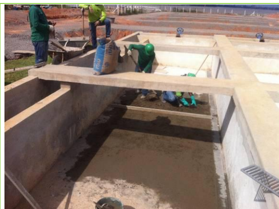
Reparo do fundo dos raceways
