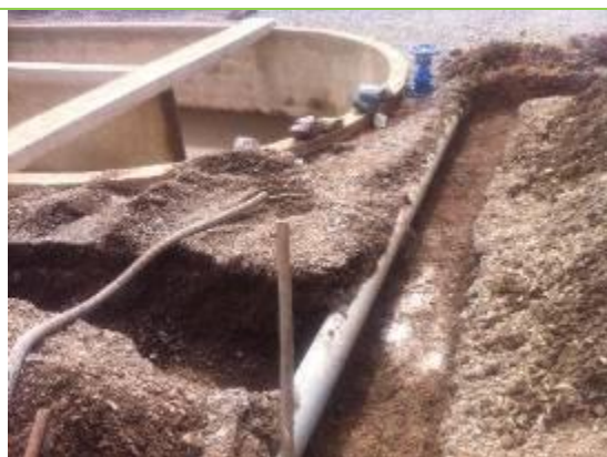
Abertura de valas para instalação do retorno dos filtros RAS
