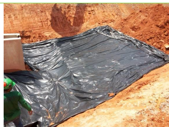
Colocação de lonas plásticas visando impermeabilização do fundo
