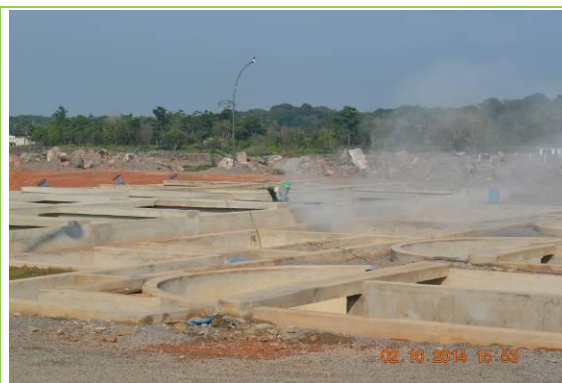
Detalhe de integrante da empresa MEKA fazendo o lixamento dos tanques Race-Ways para o recebimento de resina .
