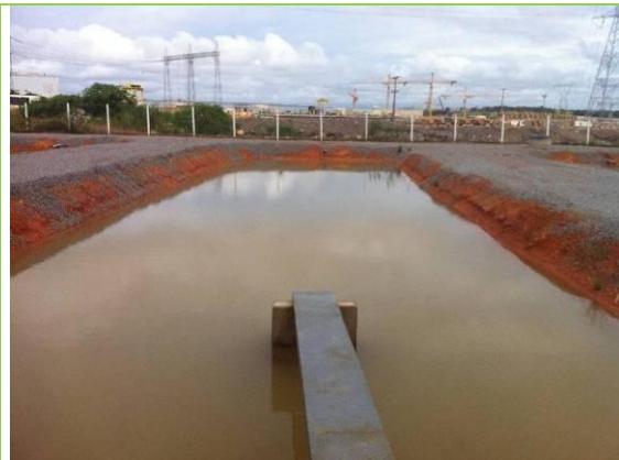
Novos testes de estanqueidade após conclusão dos trabalhos de recuperação
