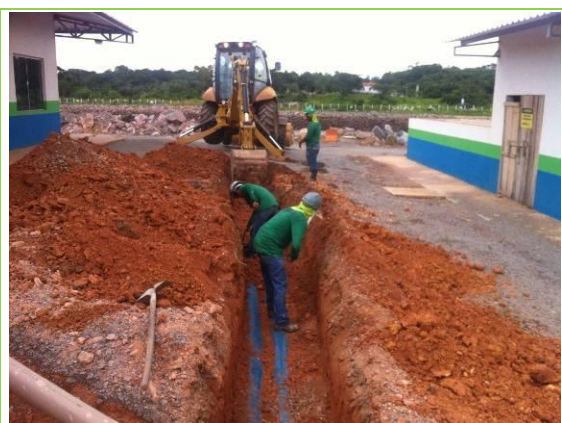
Reparo da adutora de abastecimento dos raceways para retirada de vazamentos
