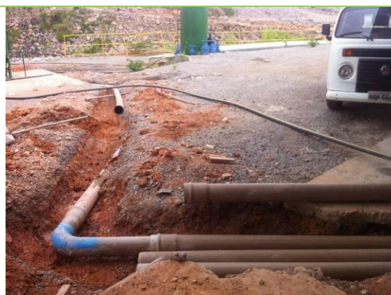
Reparo na tubulação de abastecimento de água ozonizada do LRP
