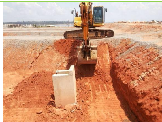
Reconformações do fundo dos tanques
