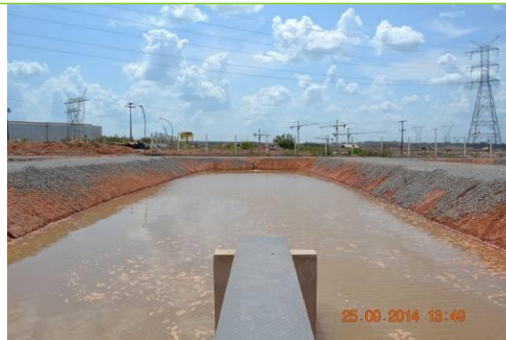
Testes de estanqueidade dos tanques escavados
