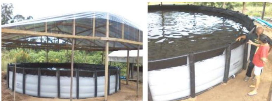
Figura 10- Montagem de tanque de piscicultura no reassentamento Santa Rita.
