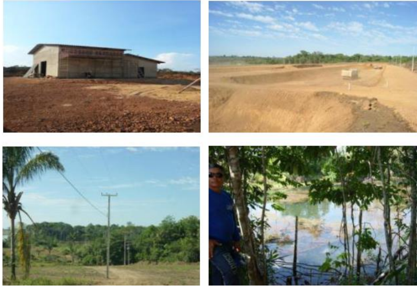
Figura 11 - Obras da estação de piscicultura na V. N. do Teotônio (Setembro/2014).
