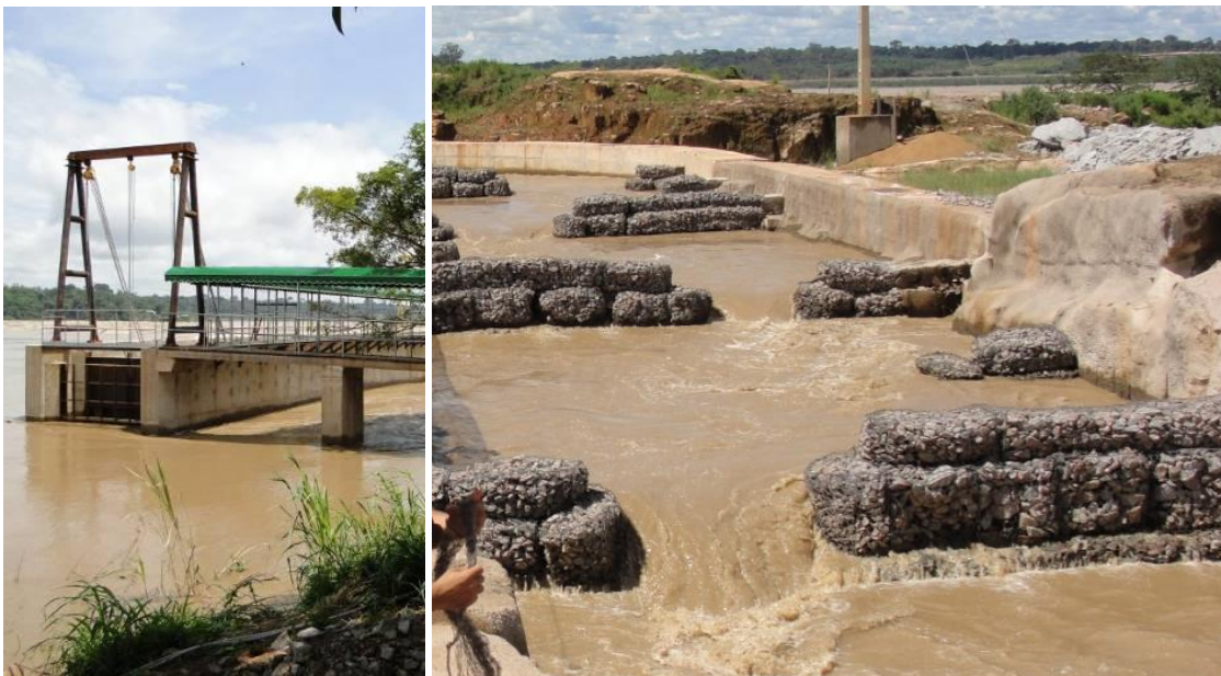
Figura 8 - Vista da tomada d'água do Canal Experimental de Transposição (esquerda) e do detalhe das ranhuras verticais no trecho superior (largura = 10m) do STP da ilha do Presídio na UHE Santo Antônio (direita).
