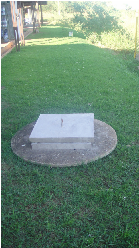
Foto 3 – Visão externa do poços da estação SANT1 após adaptação realizada.
