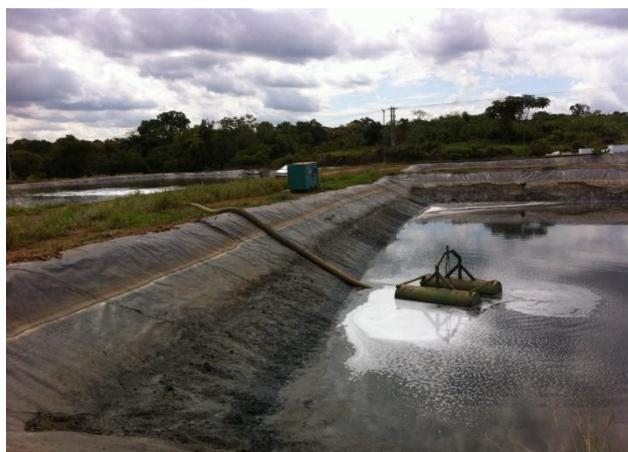
Foto 1- Bombeamento do efluente do 1º modulo para 2º modulo
