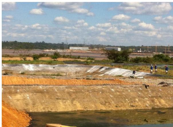
Foto 2 - Calagem do lodo com cal hidratado conforme PI CSAC 39 - PRAD
