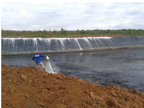
Calagem do lodo com cal hidratado conforme PI CSAC 39 - PRAD
