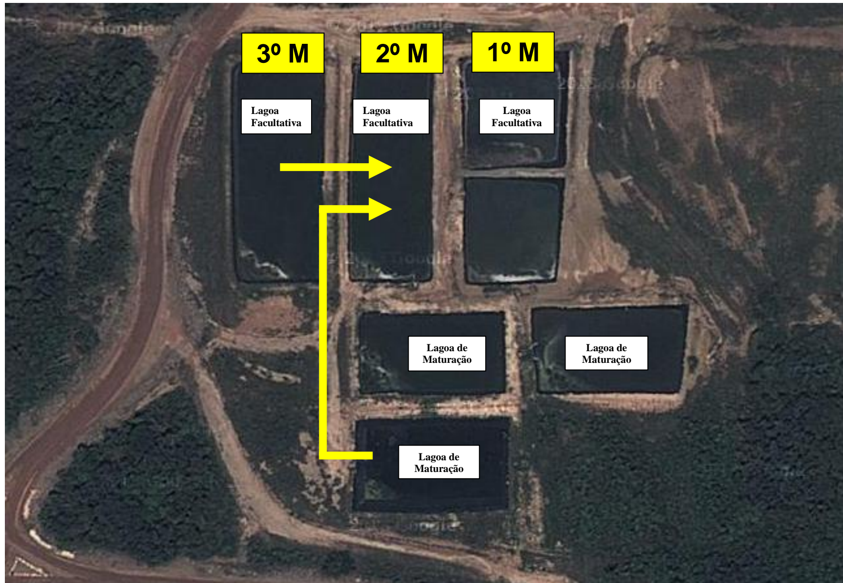
Relatório de desmobilização do 3º modulo da estação de tratamento de efluente sanitário – margem esquerda Dezembro de 2013
