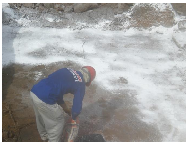
Calagem do lodo com cal hidratado conforme PI CSAC 39 - PRAD
