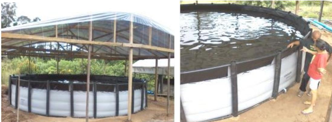
**FIGURA 22. 25:** Montagem do tanque de piscicultura no lote 88, Fonte: EMATER-RO, 2014.
