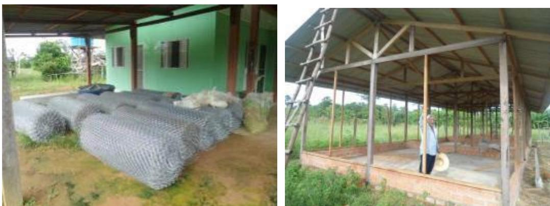
**FIGURA 22. 47:** Telas de proteção e estrutura do aviário pronto para ser telado. Fonte: EMATER-RO, 2014.
