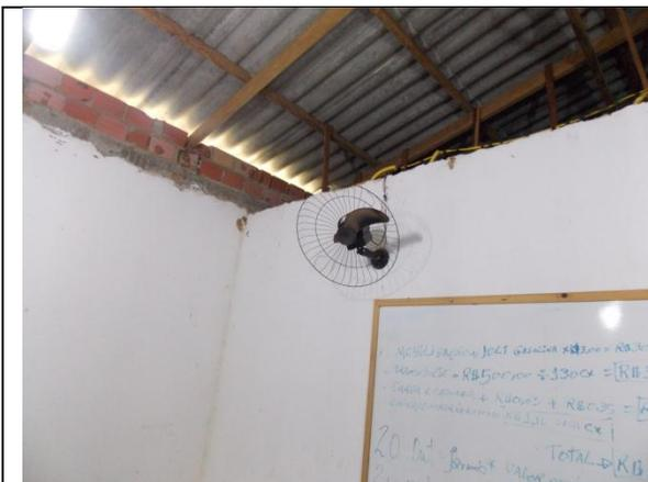
**Foto 01:** Ventiladores com as hélices quebradas e falta manutenção. **Fonte:** Instituto Fecomercio 2013.
