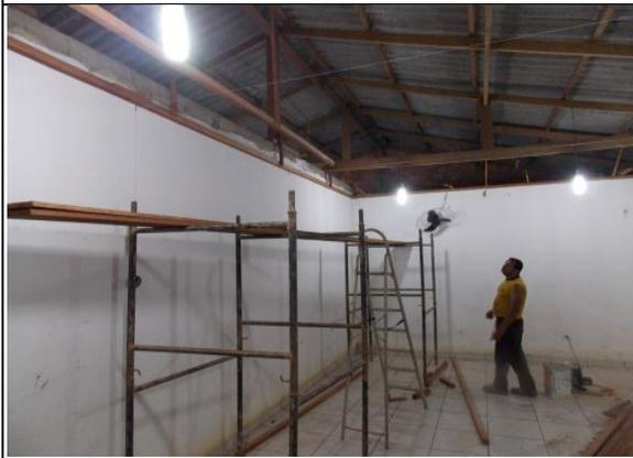
**Foto 03:** Início da colocação do forro (parte de tarugamento).
