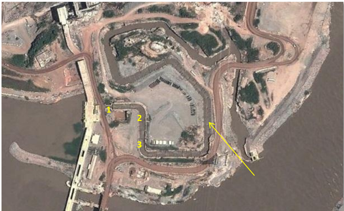
Figura 2 - Imagem de satélite mostrando o STP da ilha do Presídio, com a jusante observada à direita da imagem. A seta indica localização aproximada do início do trecho em que o NA de jusante exercia efeito sobre o do canal durante a cheia em março de 2014, e os números indicam os pontos de acesso durante a operação de resgate (imagem base do Google Earth obtida em março de 2012).
