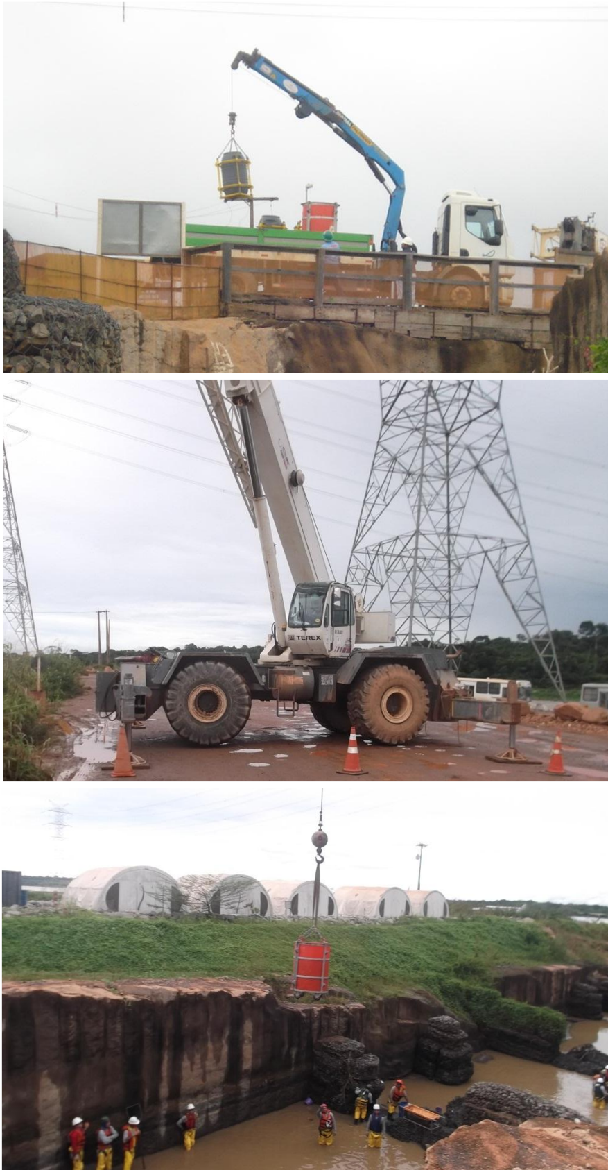
Figura 7 - Equipamentos utilizados no resgate de peixes no STP em março de 2014: utilizando caminhão Munck (acima), guindaste TEREX (meio) e bombona com armação metálica sendo içada (embaixo).
