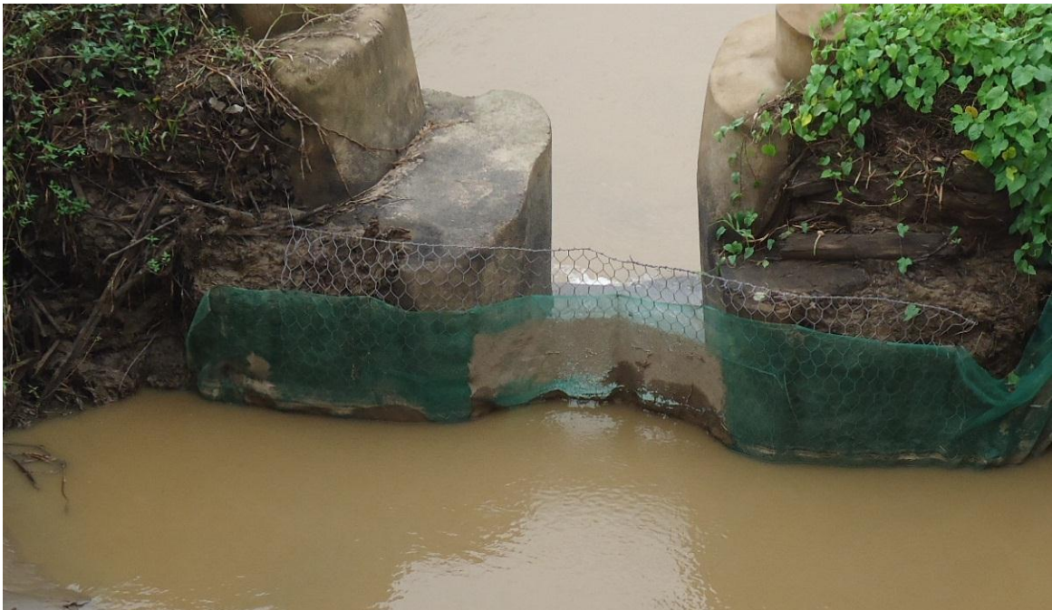
Figura 10 - Tela instalada na ranhura entre gabiões durante resgate de peixes no STP em março 2014 para impedir a subida de peixes a tanques onde a atividade fora concluída.
