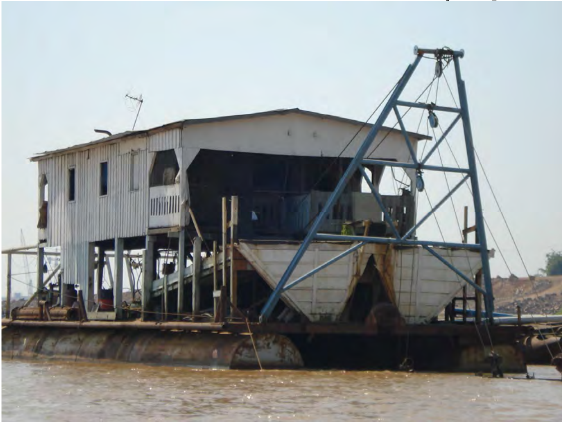
Foto da Draga Cadastrada na Ficha de N° 168
