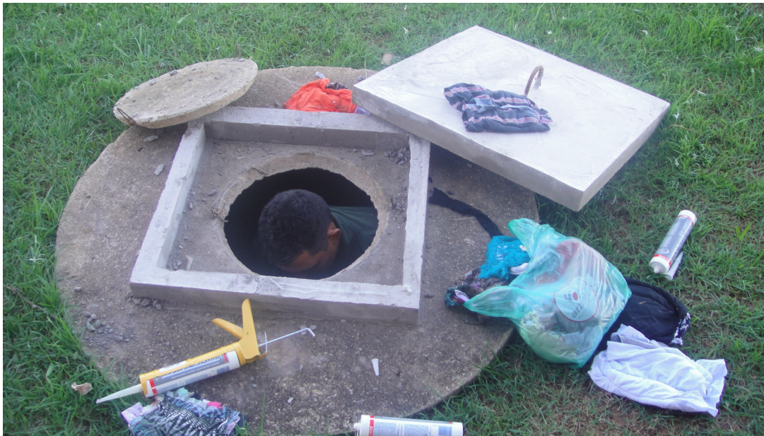
Foto 1 – Trabalho de secagem do poço anteriormente alagado da estação SANT1.
