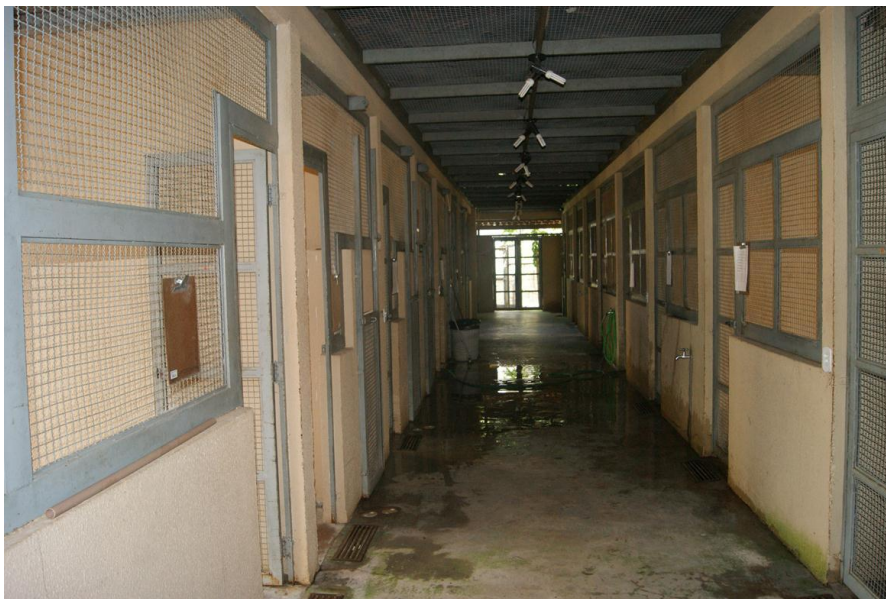
Figura 7. Recintos internos do Prédio de Atendimento / Internamento do CETAS.
