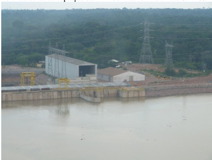
FIGURA 5: Vista aérea do ponto do local onde está o ponto de captação da CAERD na barragem da UHE Santo Antônio. Foto SAE 03/10/2013.
