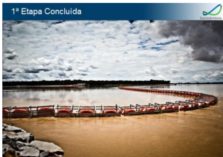
FOTO 1: Log Boom protetor da casa de força 01
