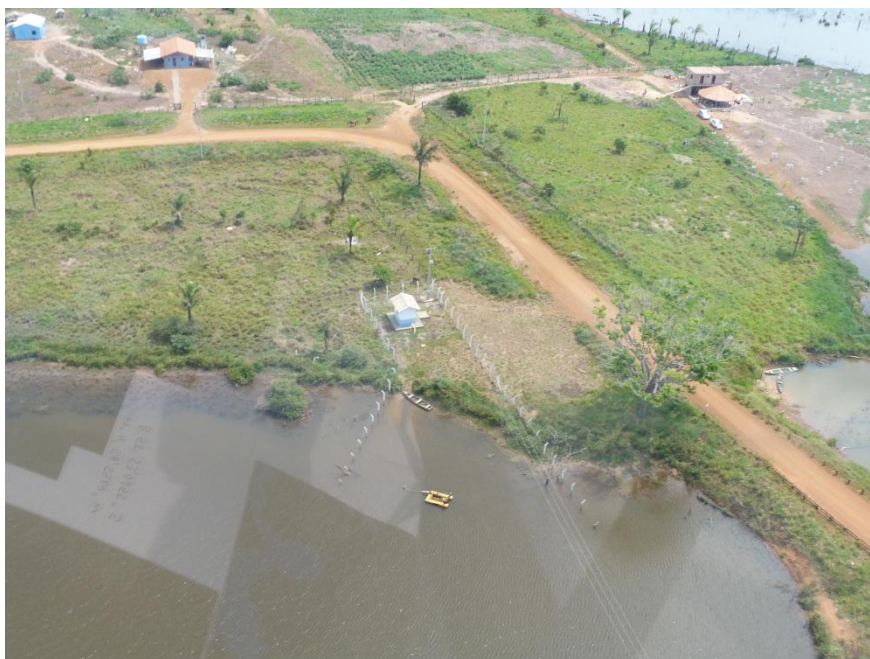
FIGURA 4: Vista aérea da captação da ETA do Riacho Azul. Foto SAE 03/10/2013.
