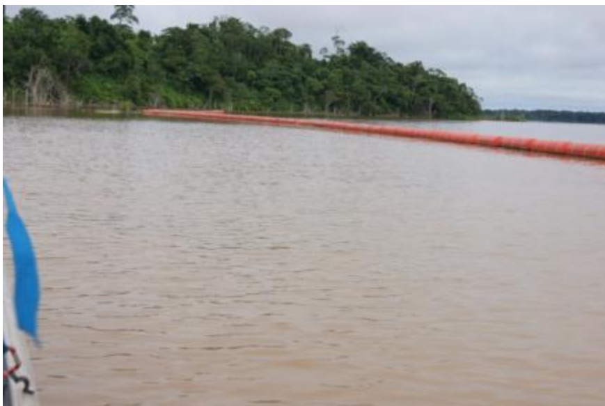
FIGURA 7: Detalhe do log boom da praia de Vila Nova de Teotônio. Foto SAE, abril/2013.
