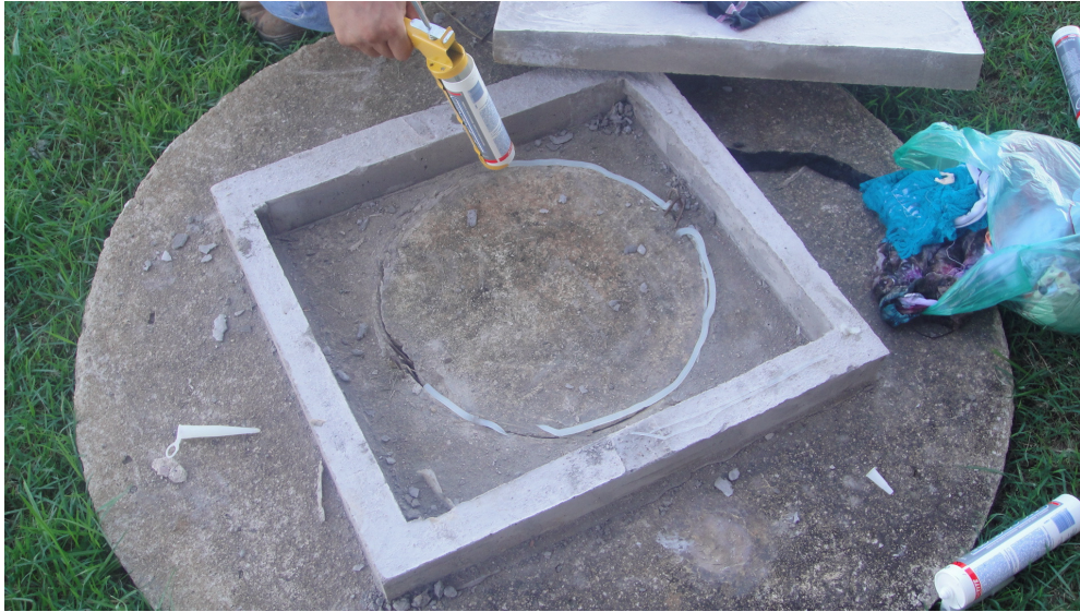
Foto 3 – Trabalho de vedação do poço da estação SANT1.
