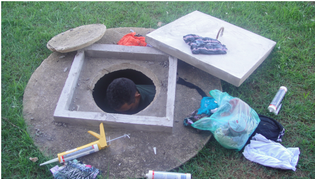
Foto 2 – Trabalho de secagem do poço anteriormente alagado da estação SANT1.
