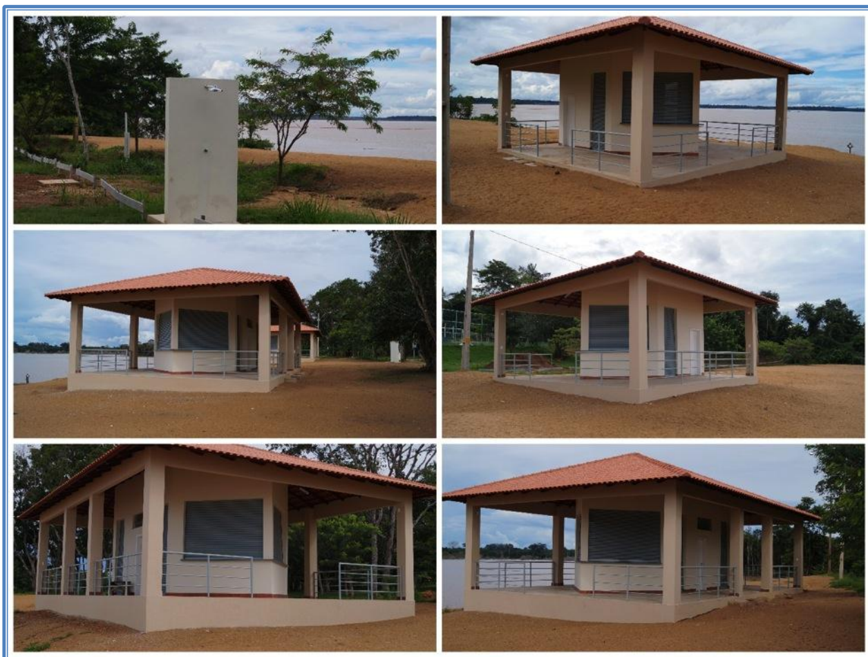
Imagem 005 - Quiosques edificados na praia artificial, construção concluída, restando a entrega a comunidade - J1 Planejamento, Pesquisa e Qualificação
