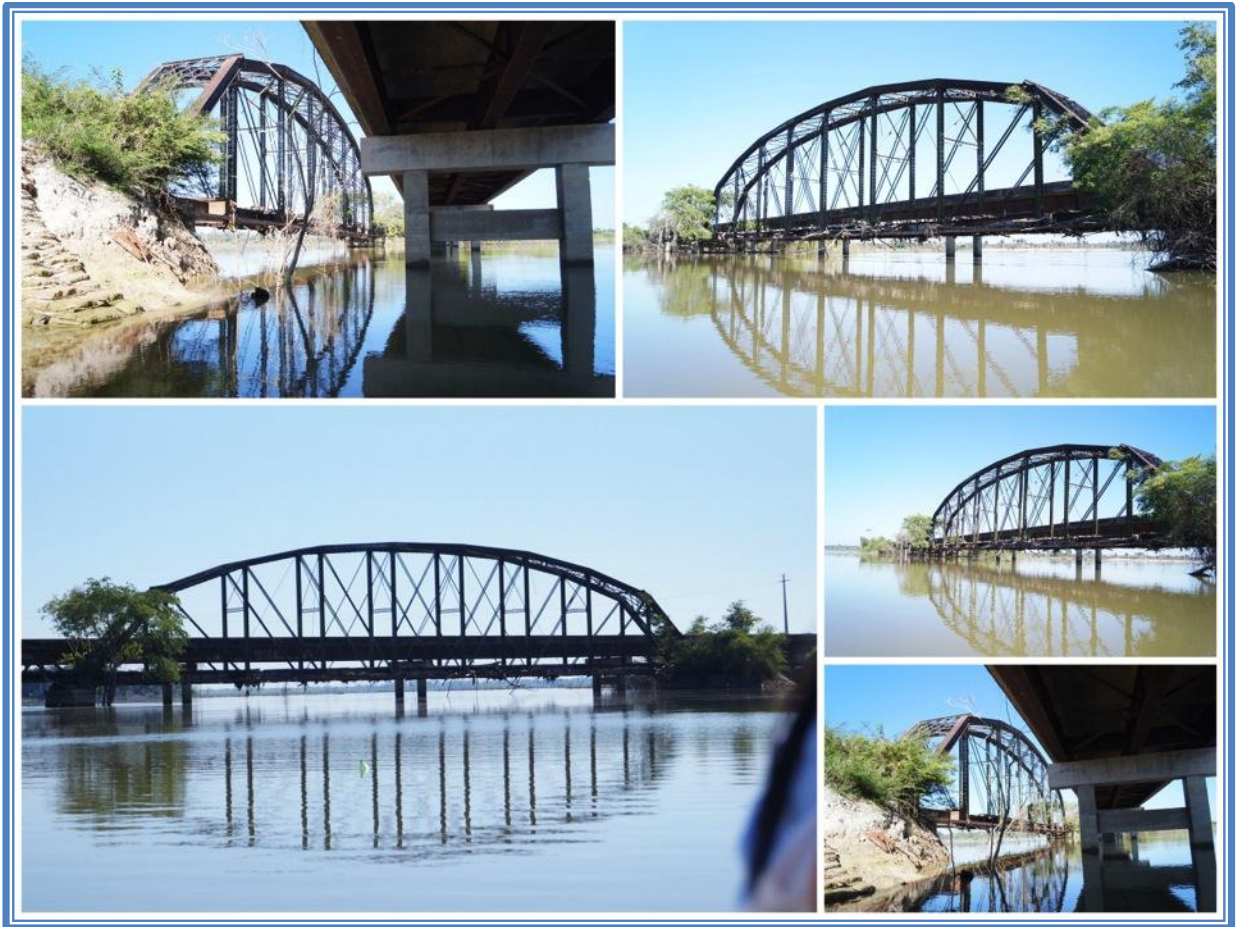
Imagem 015: Agrupamento de imagens ponte metálica de DJP – Fonte J1.
