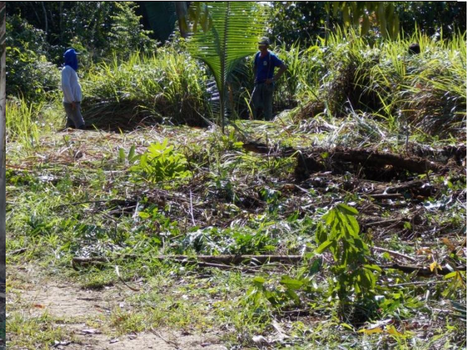
Limpeza do terreno
