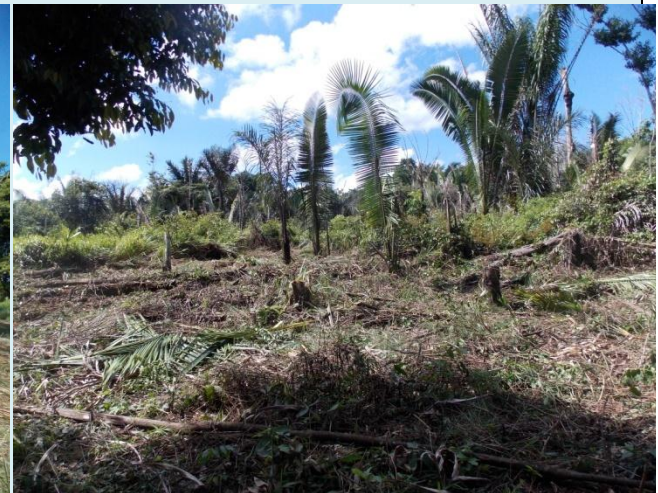
Limpeza do terreno iniciada
