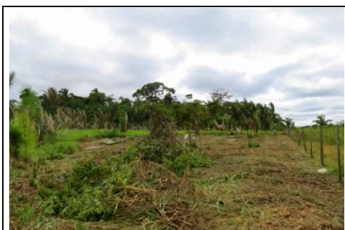
Início da limpeza do terreno Coomade linha Cujubim
