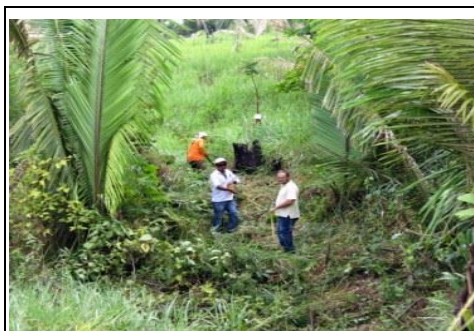
Medição da frente do terreno realizada pelo Engenheiro Civil
