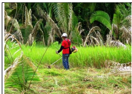
Trabalhador contratado para a limpeza do terreno.
