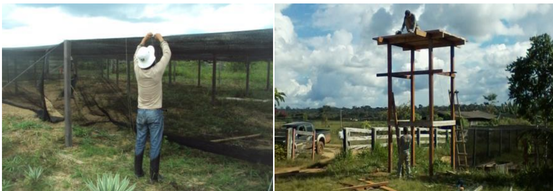
Mutirão para construção do viveiro. Fonte: EMATER – RO (2013).
