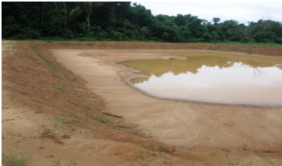
Tanque de piscicultura escavado no lote 32. Fonte: EMATER-RO (2013).
