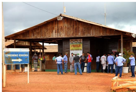
FIGURA 18. 7: Condomínio Rondônia no canteiro de obras da usina.
