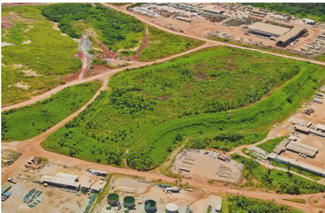
FIGURA 2. 6 - Área de bota fora 01 na ME já recuperado.
