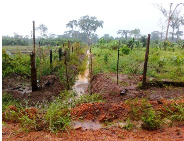
FIGURA 22. 12: Detalhe canal de drenagem – lote 41 – Santa Rita
