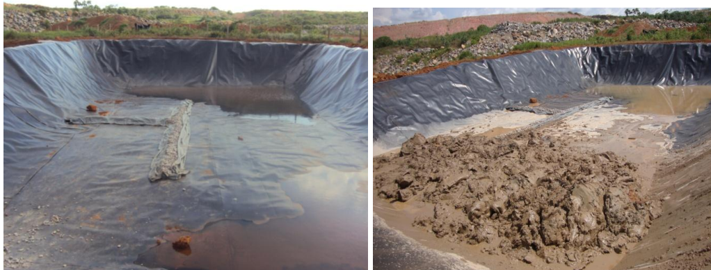
FIGURA 2. 13 - Célula impermeabilizada para o acondicionamento do material (solo) com traços de Hg.
