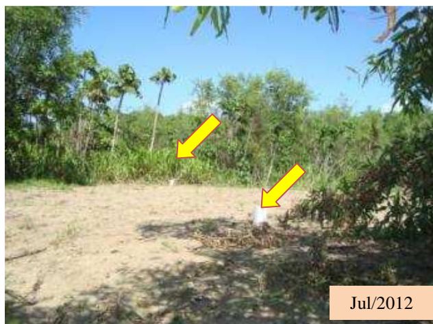
Figura 3.54. Instalação de Novos Marcos de Referência no Local de Monitoramento 12 durante o Levantamento de Julho/2012
