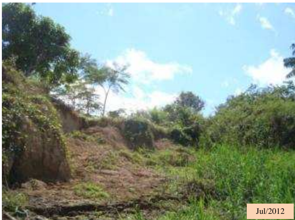
Figura 3.16. Vista Geral do Talude no Local de Monitoramento 3 em Julho/2012
