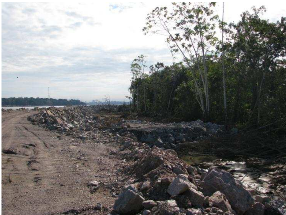
Figura 3.6. Vista do Enrocamento nas Imedições do LM-1
