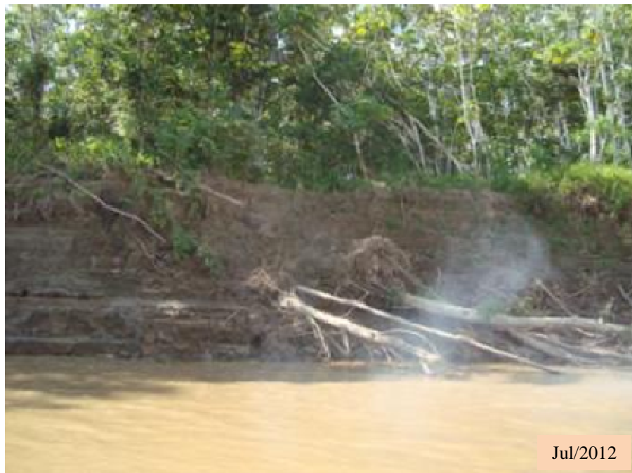
Figura 3.25. Vista Geral da Margem no Local de Monitoramento 5 em Julho/2012
