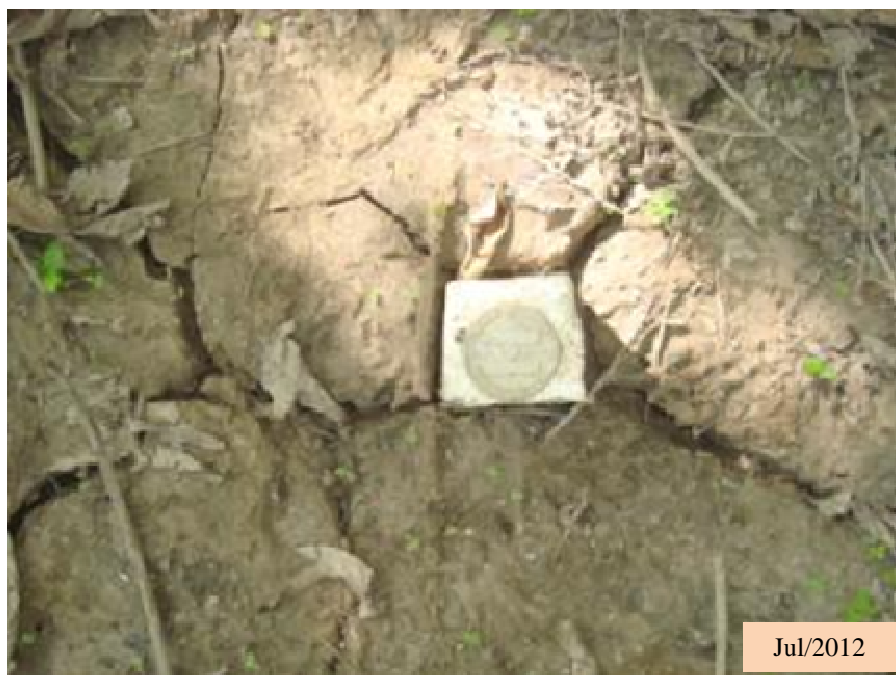
Figura 3.27. Situação do Marco de Referência RN 3 no Local de Monitoramento 5
