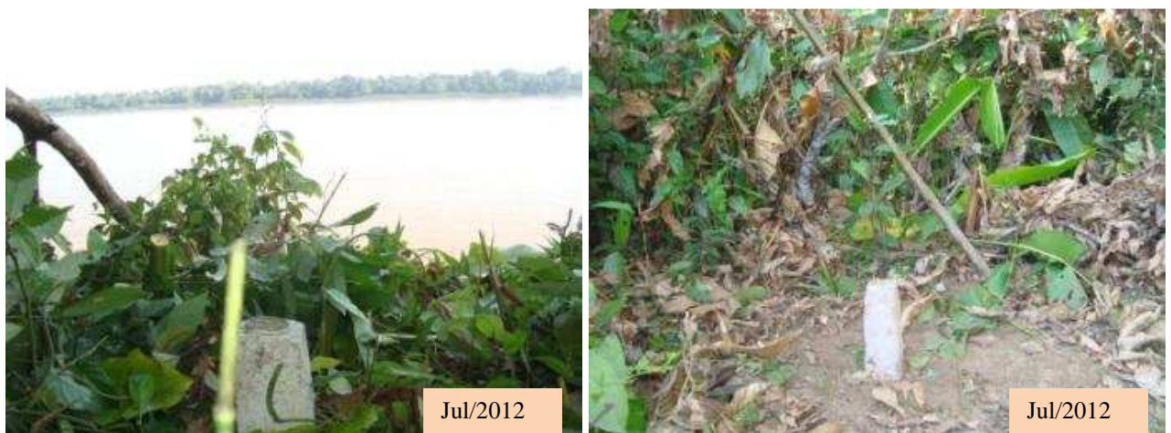
Figura 3.36. Instalação dos Marcos de Referência no Local de Monitoramento 7
