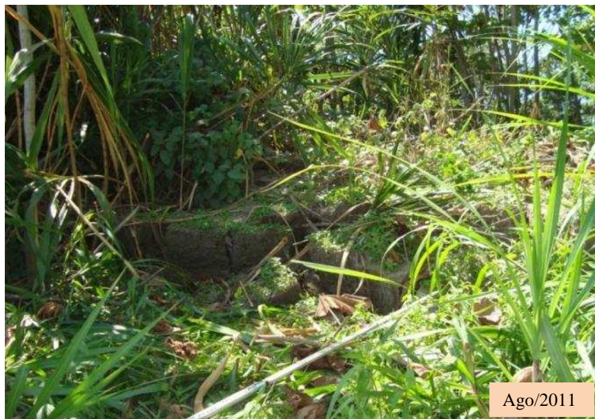
Figura 3.10. Vista Parcial do Afundamento da Margem no Local de Monitoramento 2
