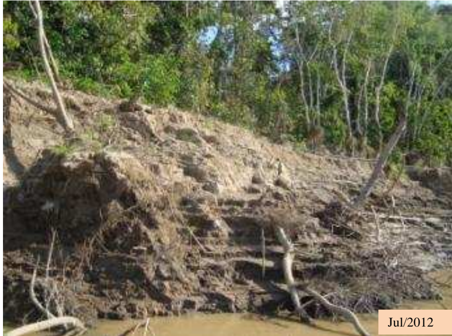
Figura 3.30. Vista Geral da Linha de Margem no LM-6 em Julho/2012
