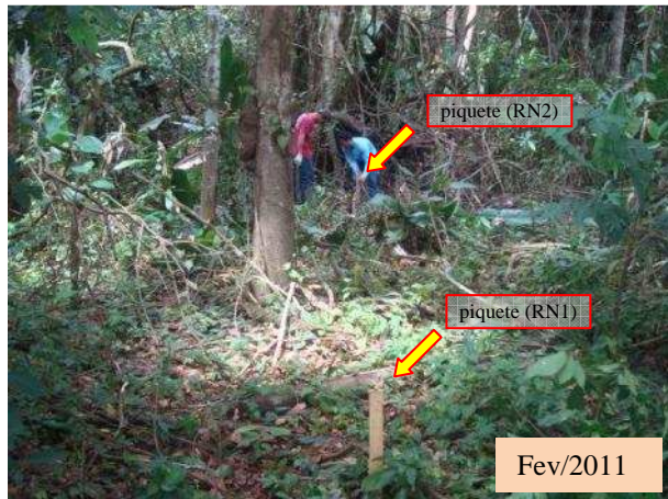
Figura 3.45. Instalação dos Piquetes e Marcos de Referência no Local de Monitoramento 10
