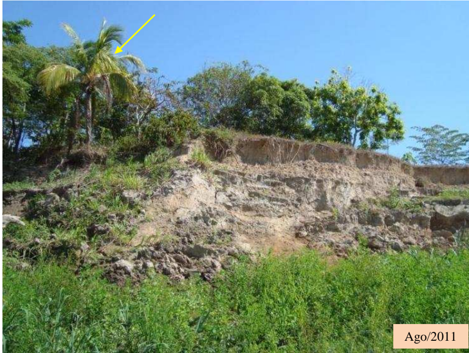
Figura 3.15. Vista Geral da Margem no Local de Monitoramento 3 em Agosto/2011
