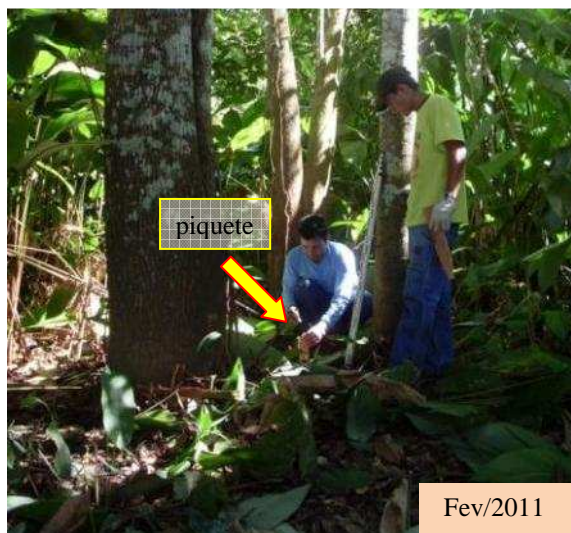
Figura 3.31 Instalação do Piquete e do Marco de Referência no Local de Monitoramento 6
