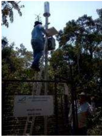
Início da inspeção
