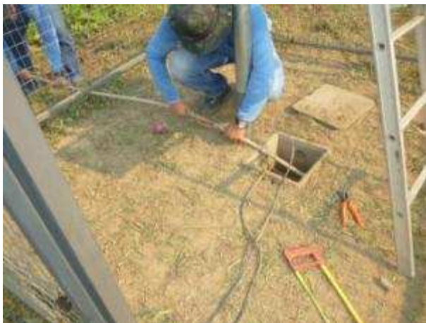
Emenda de tubos para nova instalação
