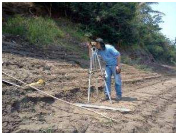
Nivelamento da estação
