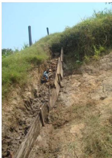
Concretagem da tubulação.
