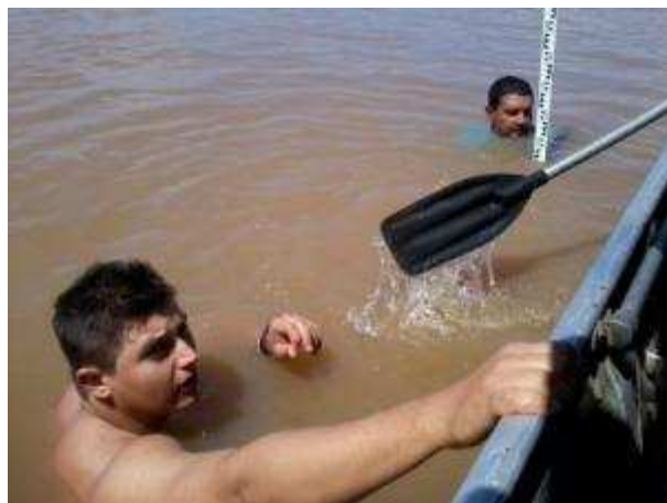
Instalação do prolongamento da tubulação de 50 mm.
