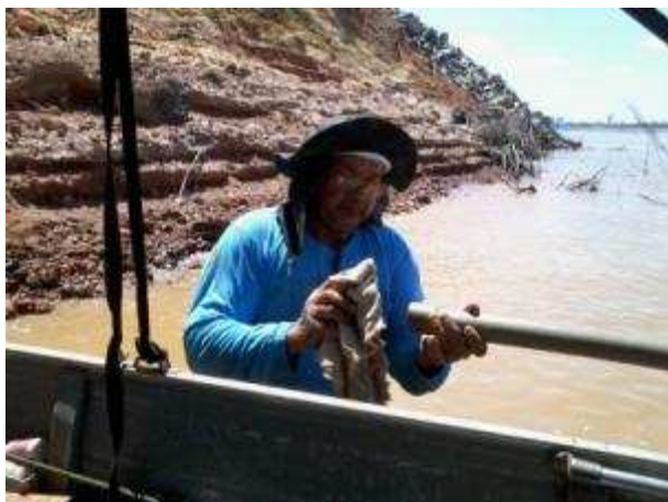
Instalação do prolongamento da tubulação de 50 mm.
