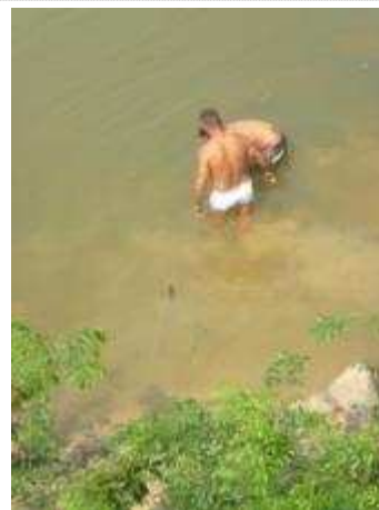
Verificação se há obstrução ou muito sedimento no local onde está alojado a boca do cano de 50 mm
