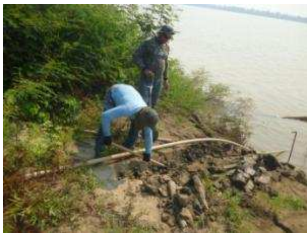
Escavação para enterrar o tubo
