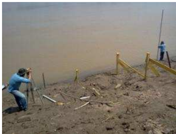
Nivelamento da estação
