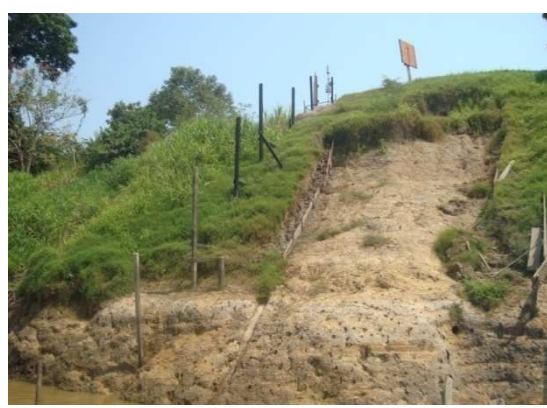
Tubulação concretada.
