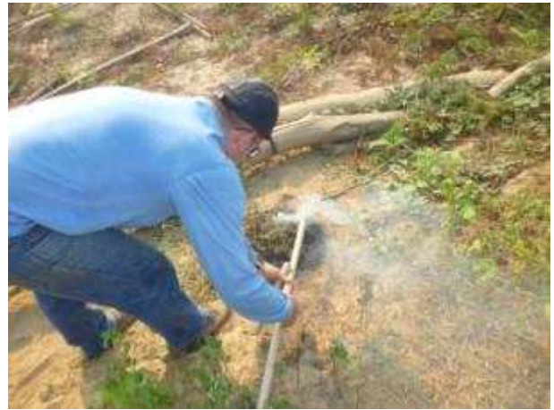
Tubo 25 mm para inserir na nova instalação
