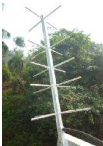
Limpeza da antena
