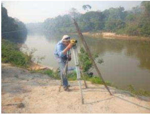
Nivelamento da estação
