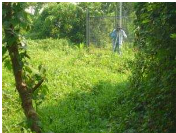
Nivelamento da estação
