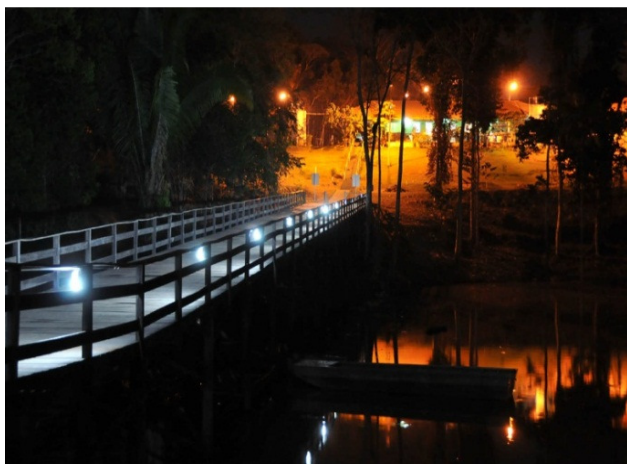
Figura 1: Iluminação do Pier
