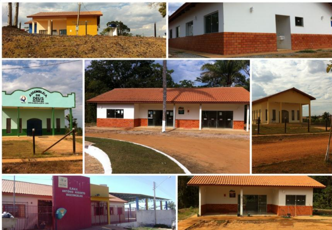
Imagem 009: Posto de saúde, Associação de Moradores, Igreja Assembleia de Deus, Igreja Católica, Escola Municipal e Associação dos Pescadores.
