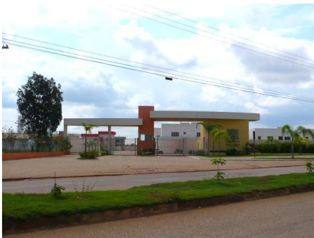
Foto 14 - Vista do condomínio localizado a subárea 7B. Notar que as edificações internas e guarita de entrada encontram-se já acabadas.
