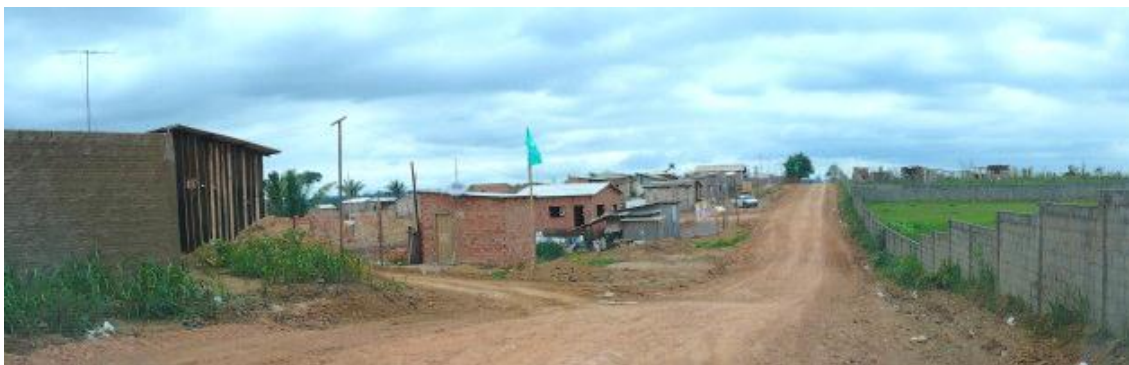
Foto 31–Vista da ocupação Monte Sinai. Notar adensamento da área e estrutura das edificações.
