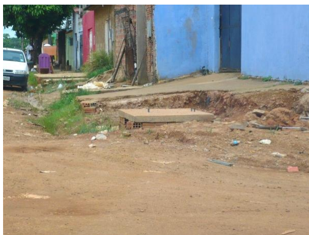
Foto 27 - Vista da Rua Espírito Santo. Notar Boca-de-lobo recém instalada no local, o que evidencia a implantação de sistema de drenagem pluvial.
