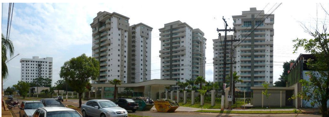
Foto 47 - Vista de empreendimento localizado na Av. Lauro Sodré. Notar finalização das obras civis.
