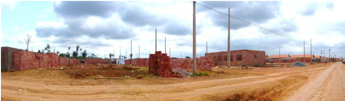
Foto 29 - Vista dos dois condomínios de menor porte sendo instalados no interior da Área 11.
