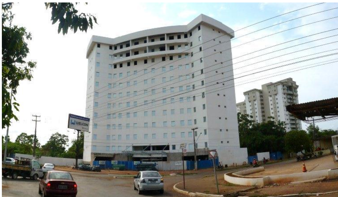
Foto 48 - Vista do hotel localizado na esquina das avenidas Lauro Sodré e dos Imigrantes. Notar avanço das obras, acabamento externo finalizado e instalação das esquadrias.
