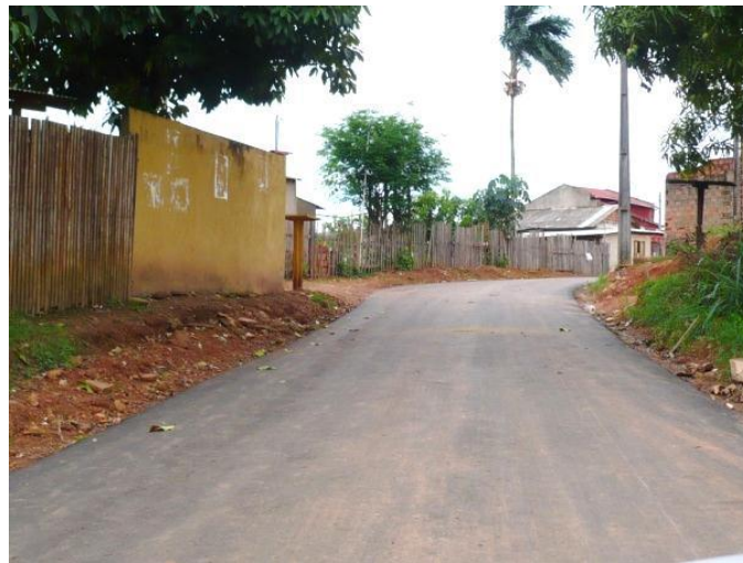
Foto 23 - Vista da Rua Ápia, bairro Nova Floresta. Notar pavimentação asfáltica recém executada.
