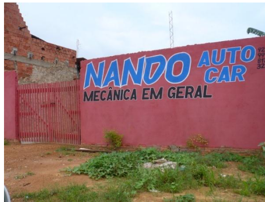
Foto 39 - Vista de edificação no interior do bairro Mariana. Exemplo de uso misto no local, residencial e serviço de baixa complexidade.
