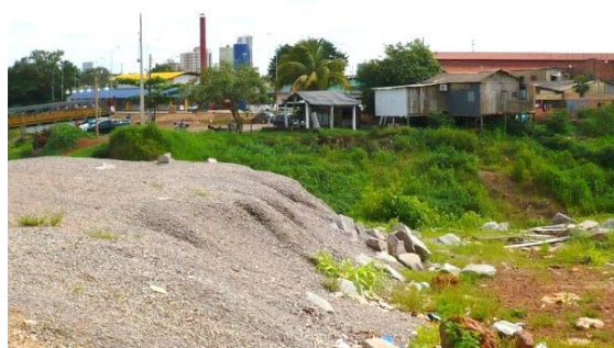
Foto 53 - Vista do porto Cai-N'água. Notar o novo edifício de apoio aos passageiros.
