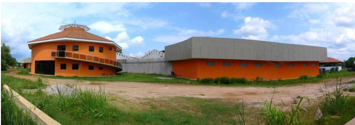
Foto 45 - Vista de terreno na porção sul da Área 17. Notar estágio avançado de construção das edificações.
