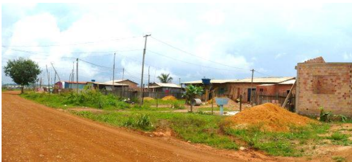
Foto 41 - Vista de residências no interior da ocupação Porto Cristo. Notar a melhoria das edificações.
