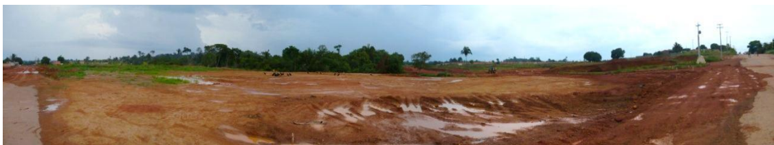
Foto 7 - Vista panorâmica a partir da Avenida Mamoré para o terreno onde está sendo implantado o loteamento Novo Horizonte. Notar falta de movimentação para implantação de obras complementares de infraestrutura.
