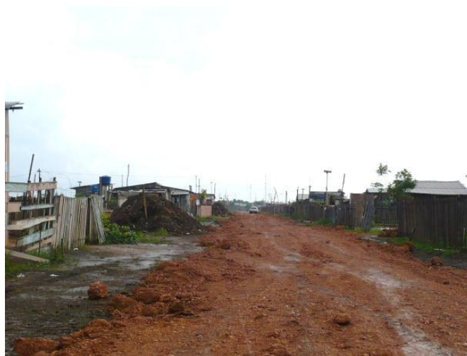
Foto 44–Vista de via interior ao loteamento irregular. Notar cascalhamento recém executado.
