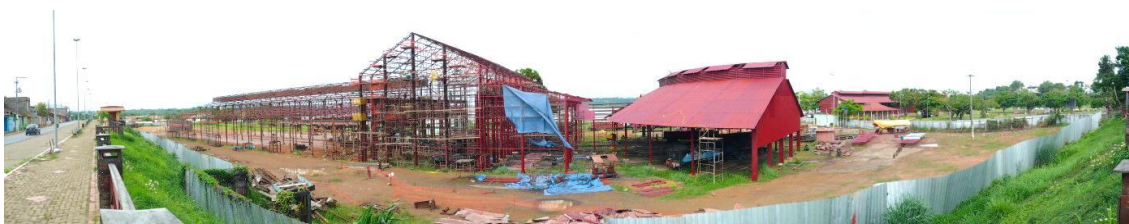
Foto 51 - Vista da Estação Madeira-Mamoré. Notar obras de restauração das edificações e instalações do entorno.
