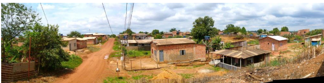
Foto 33 - Vista geral da porção sul da Área 12. Notar maior adensamento da gleba. Notar rede elétrica clandestina que comprova a falta de infraestrutura no local.
