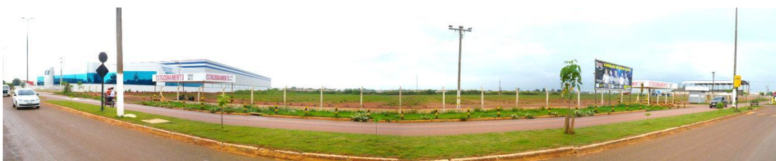
Foto 17 - Vista do terreno marginal à Avenida Mamoré. Notar galpão à esquerda com obras concluídas
