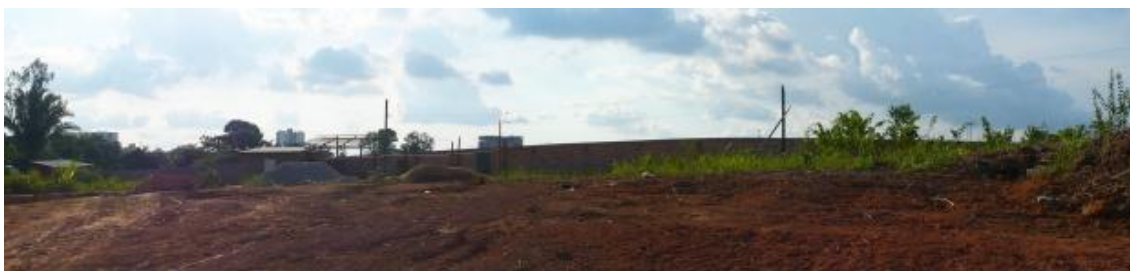
Foto 2 - Vista da porção nordeste da Área 1, a partir da Estrada da Penal. Notar trabalhos de cercamento do terreno.
