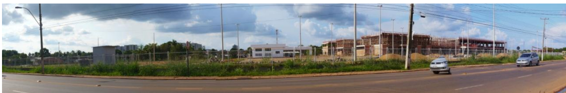
Foto 4 - Vista panorâmica de toda a face frontal do Instituto Federal de Educação, Ciência e Tecnologia, a partir da Av. Calama. Notar à direita, estágio das obras estruturais e de vedação dos edifícios.
