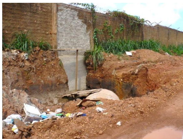
Foto 46 - Obras de implantação de manilhas de concreto para melhoria do sistema de drenagem na Rua Açai.
