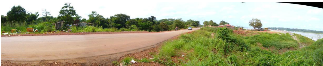
Foto 49 - Vista da Rua Madeira-Mamoré. Notar à esquerda a via asfaltada e as margens da via desocupadas. A direita, notar encostas do igarapé desocupadas.
