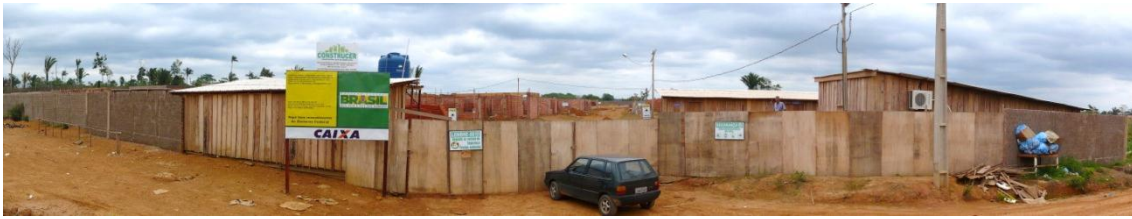
Foto 28 - Vista do Condomínio Nova Era III. Notar residências no interior do loteamento.
