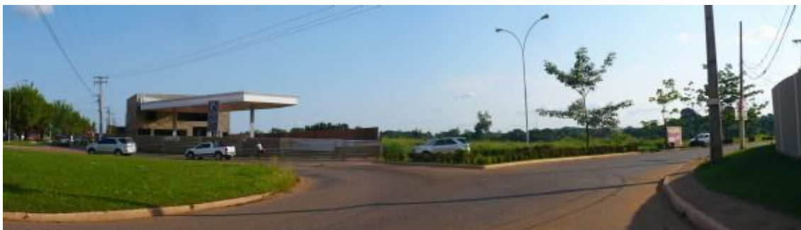
Foto 3 - Vista da esquina da Avenida dos Imigrantes (à direita da foto) e Rua Guaporé (à esquerda). Observar posto de gasolina em fase final de construção.
