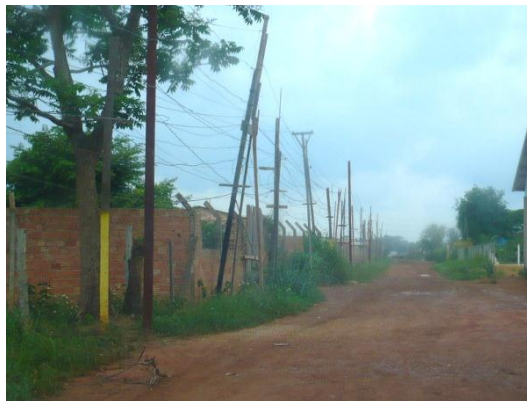
Foto 40 - Vista de via da ocupação Porto Cristo. Notar posteamento para distribuição clandestina de energia evidenciando a falta de melhorias na infraestrutura do local.
