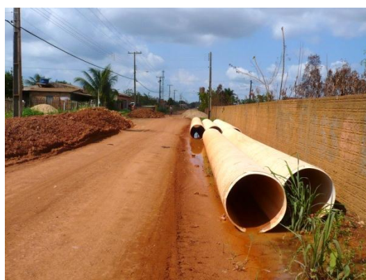
Foto 12 - Vista da Rua Piramutunga no interior do bairro Lagoa. Notar, à direita, tubulação de drenagem a ser instalada, e à esquerda, terra oriunda da abertura de valas para instalação da rede.
