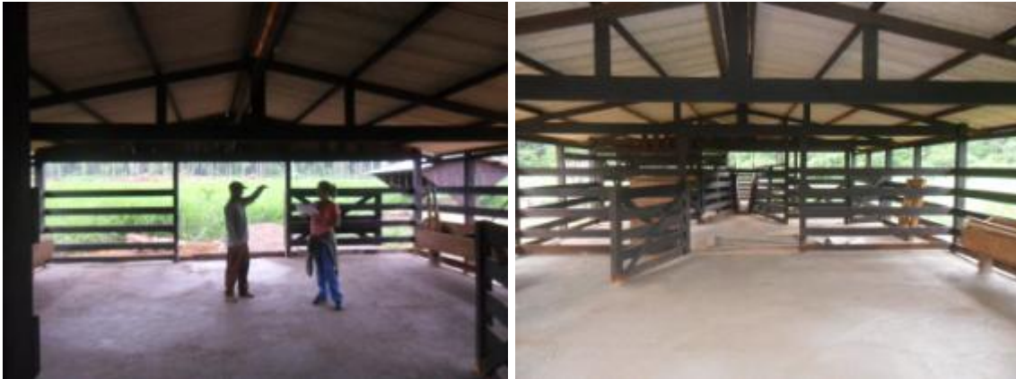
Curral acabado de acordo com as especificações técnicas no lote 131.
