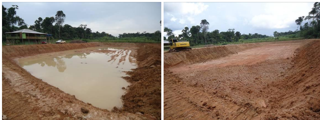
Construção de tanques de peixes no lote 16. Fonte: EMATER-RO 2012.
