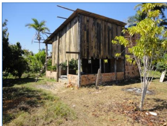
Construção de galpão aviário, lote 09. Fonte: EMATER-RO.
