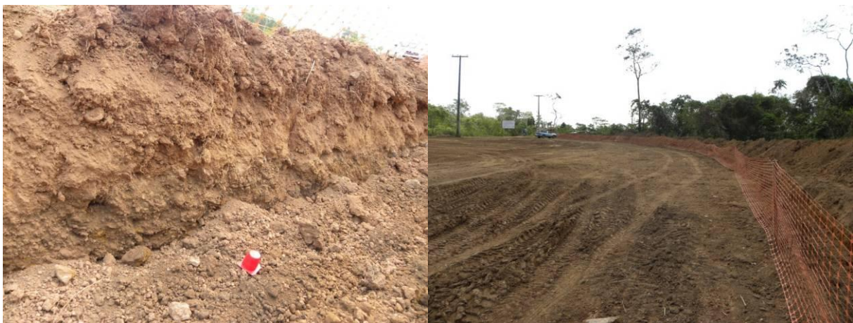
Figura 14 e Figura 15. Área do Estacionamento, terraplanagem.
