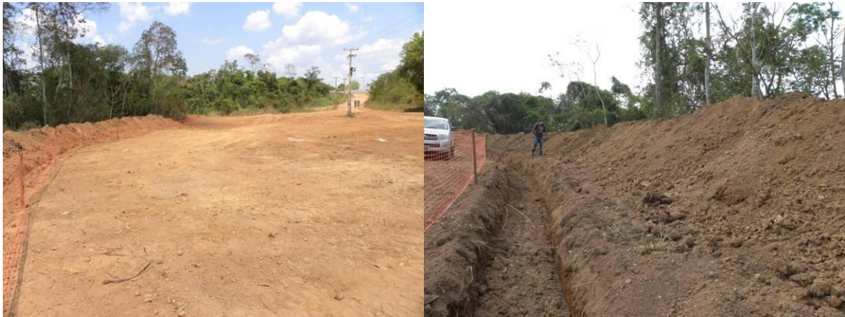
Figura 12 e Figura 13. Área do Estacionamento, terraplanagem.
