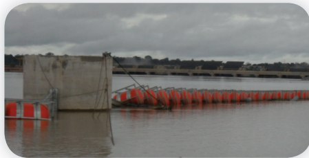
Log Boom do canteiro de obras da Usina Santo Antônio
