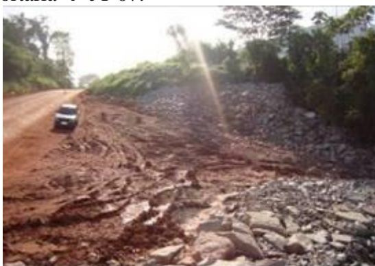
FIGURA 2. 18: Açã de melhoria no AMD 07 – estabilizaã dos taludes laterais do acesso AMD 07 com utilizaã de enrocamento.
