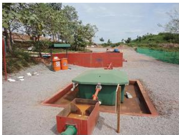
FIGURA 2. 11: Efluente oleoso após o tratamento físico de separação do óleo da água, sendo enviado ao tratamento de reuso da água.
