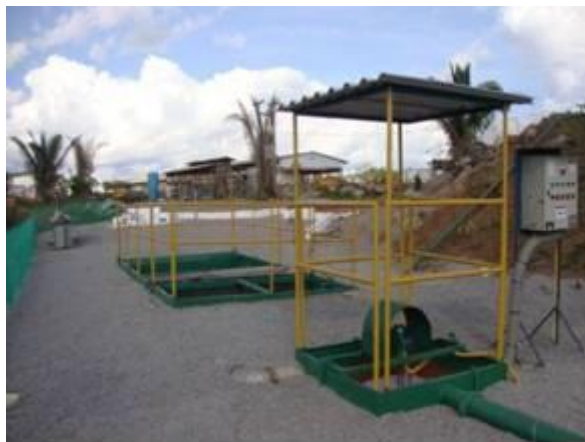
FIGURA 2. 13: Misturador para homogeneizar os coagulantes adicionados no efluente.
