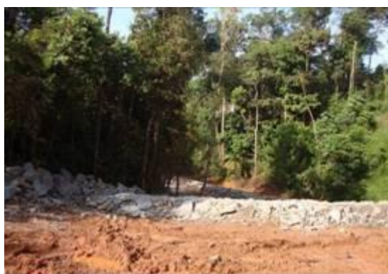
FIGURA 2. 16: Ação de melhoria no AMD 07 – estabilização dos taludes laterais do acesso AMD 07 com utilização de enrocamento.
