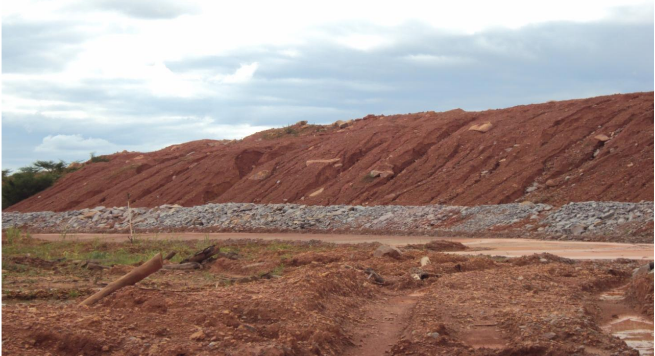
Figura nº 16. 10/04/2010 - Sequência de fotos do Bota fora 2 (solo) – 02/03. Reconformação da superfície do talude, lançamento de camada de solo vegetal e plantio de forrageiras
