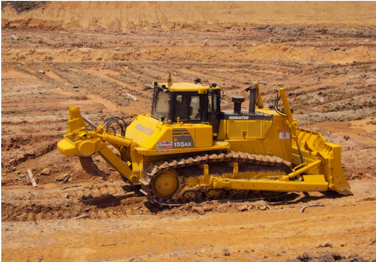
Figura nº 11. 11/01/2011 – Detalhe do equipamento utilizado para abertura dos sulcos em nível na superfície do terreno da jazida JT 07 - MD.
