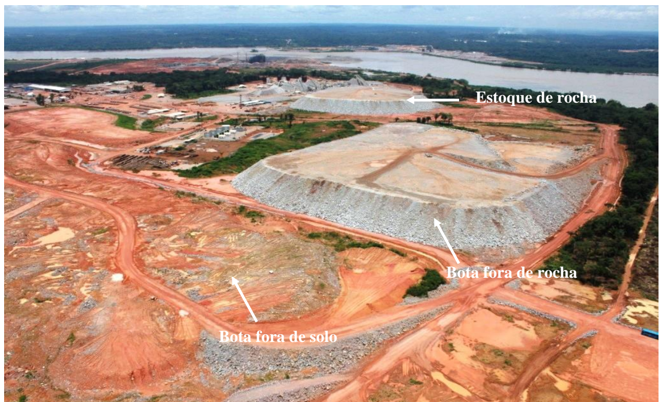
Figura nº 14. 1512/2009 - Vista aérea de Bota fora de rocha e de solo
