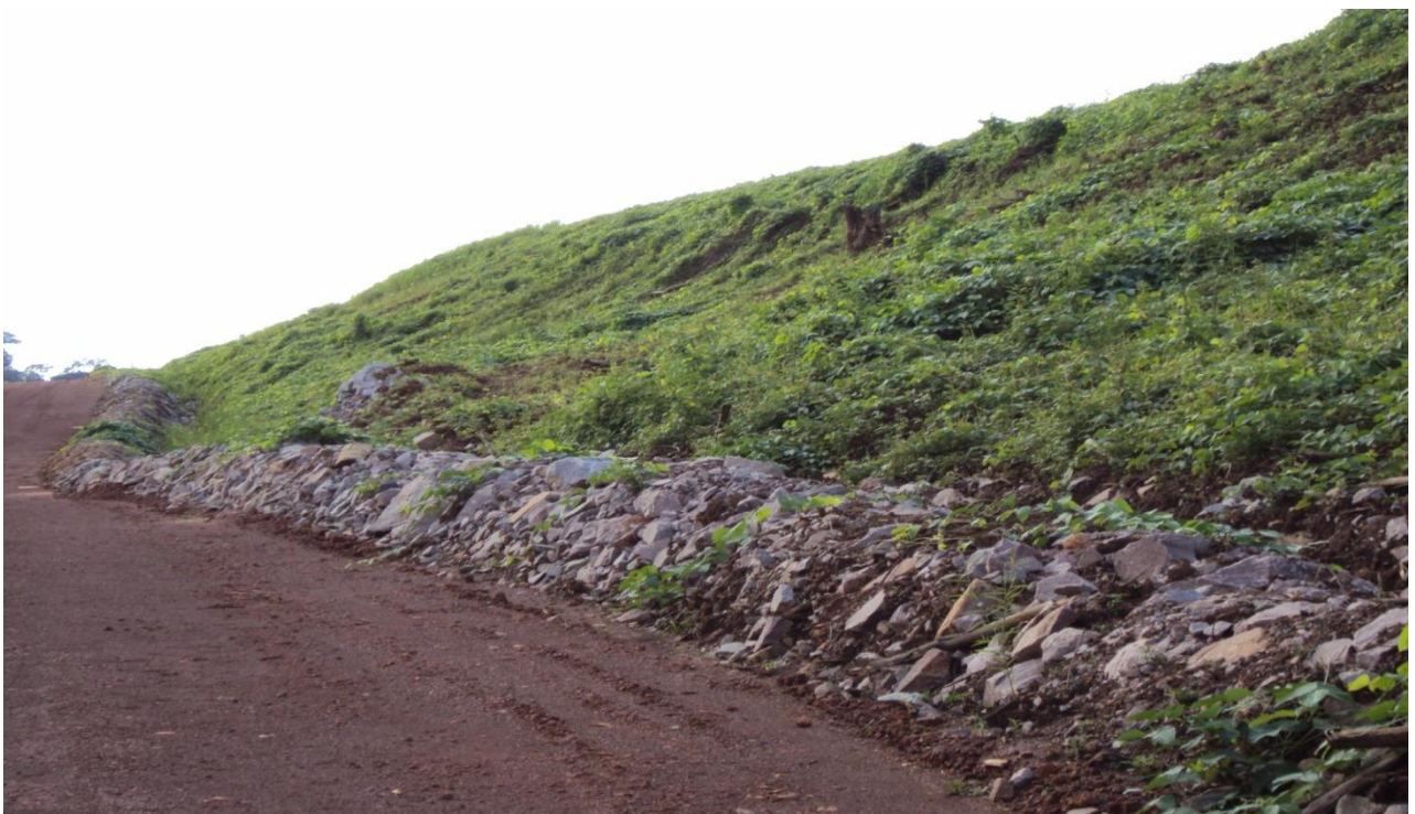
Figura nº 16. 10/04/2010 - Sequência de fotos do Bota fora 2 (solo) – 02/03. Reconformação da superfície do talude, lançamento de camada de solo vegetal e plantio de forrageiras
