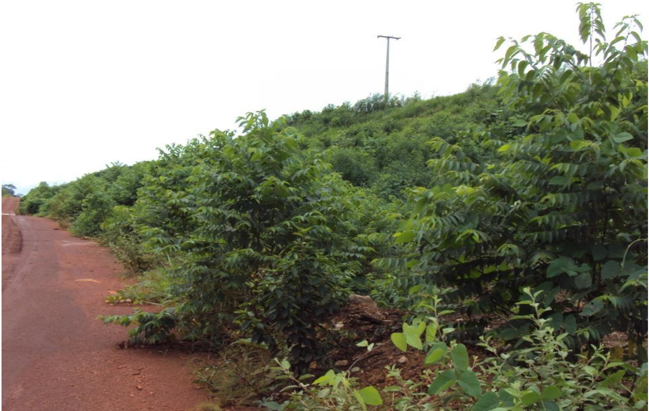
Figura nº 17. 18/12/2010 - Seqüência de fotos do Bota fora 2 (solo) – 03/03. Estabilização do talude recuperado, evidenciando o início do processo de sucessão natural da vegetação, com ocorrência natural de espécies arbóreas e arbustivas nativas
