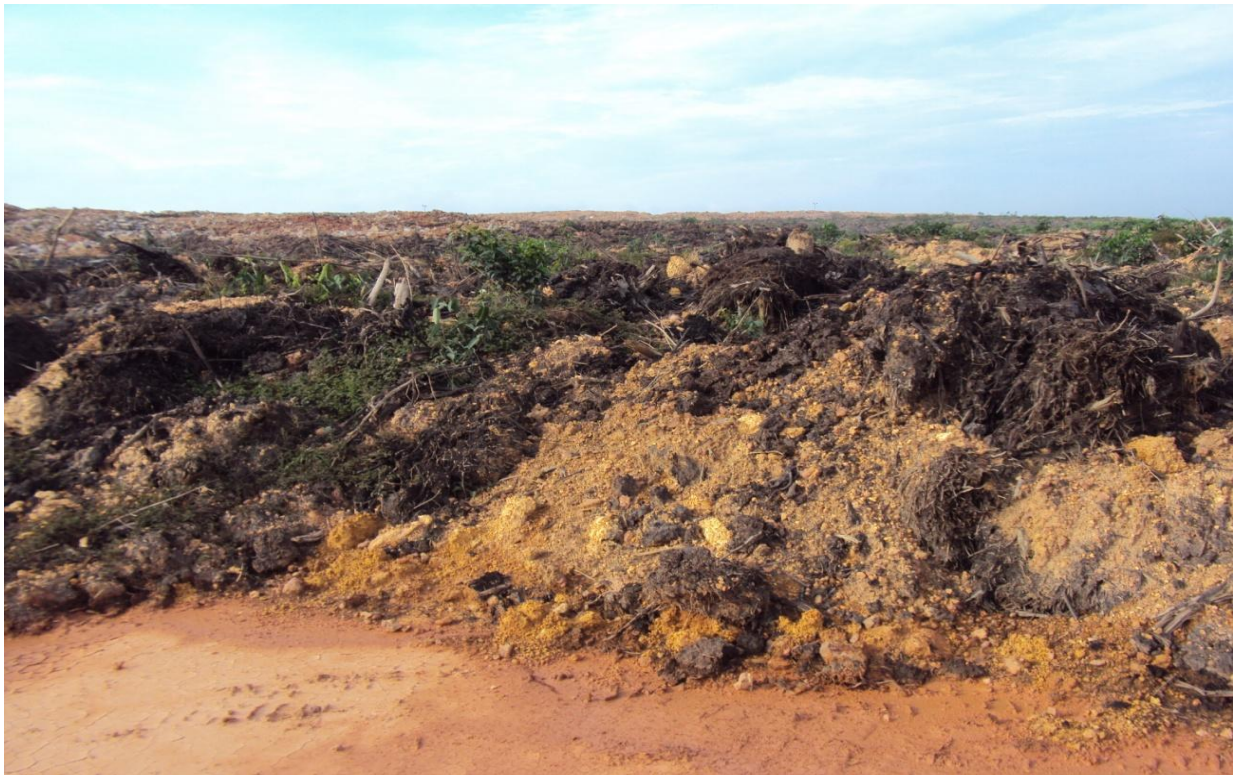
Figura nº 8. 14/10/2010 - Estoque de solo vegetal (F) na margem esquerda, Tabela 7, (material proveniente do decapeamento do igapó)
