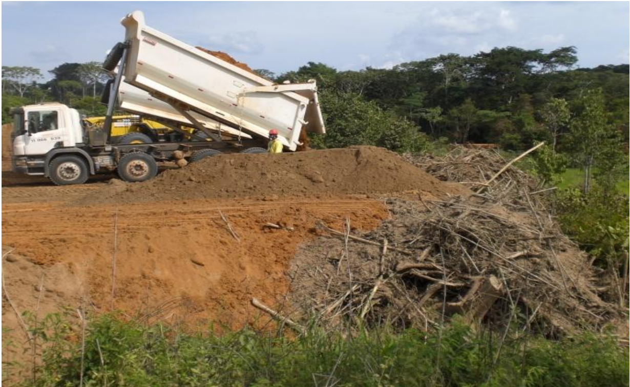
Figura nº 8. 14/10/2010 - Estoque de solo vegetal (F) na margem esquerda, Tabela 7, (material proveniente do decapeamento do igapó)
