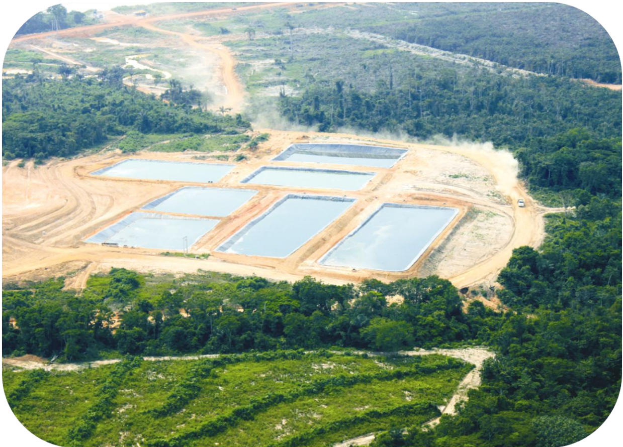
Figura nº 34. 07/10/2010 – ETE da ME – Estruturas modulares (3 módulos) compostos por lagoas facultativas e aeróbicas
