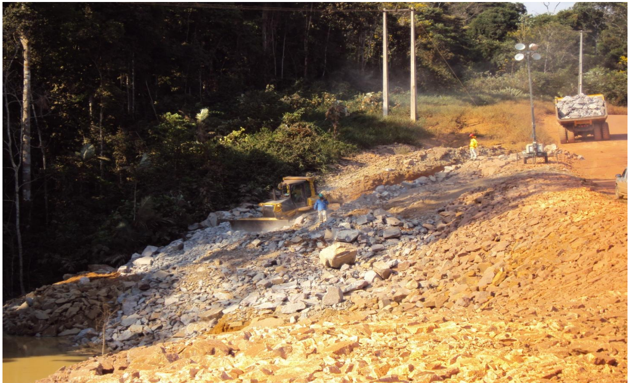
Figura nº 30. 07/12/2010 – Instalação de proteção de crista no aterro do acesso, conformação de drenagem e plantio de taludes
