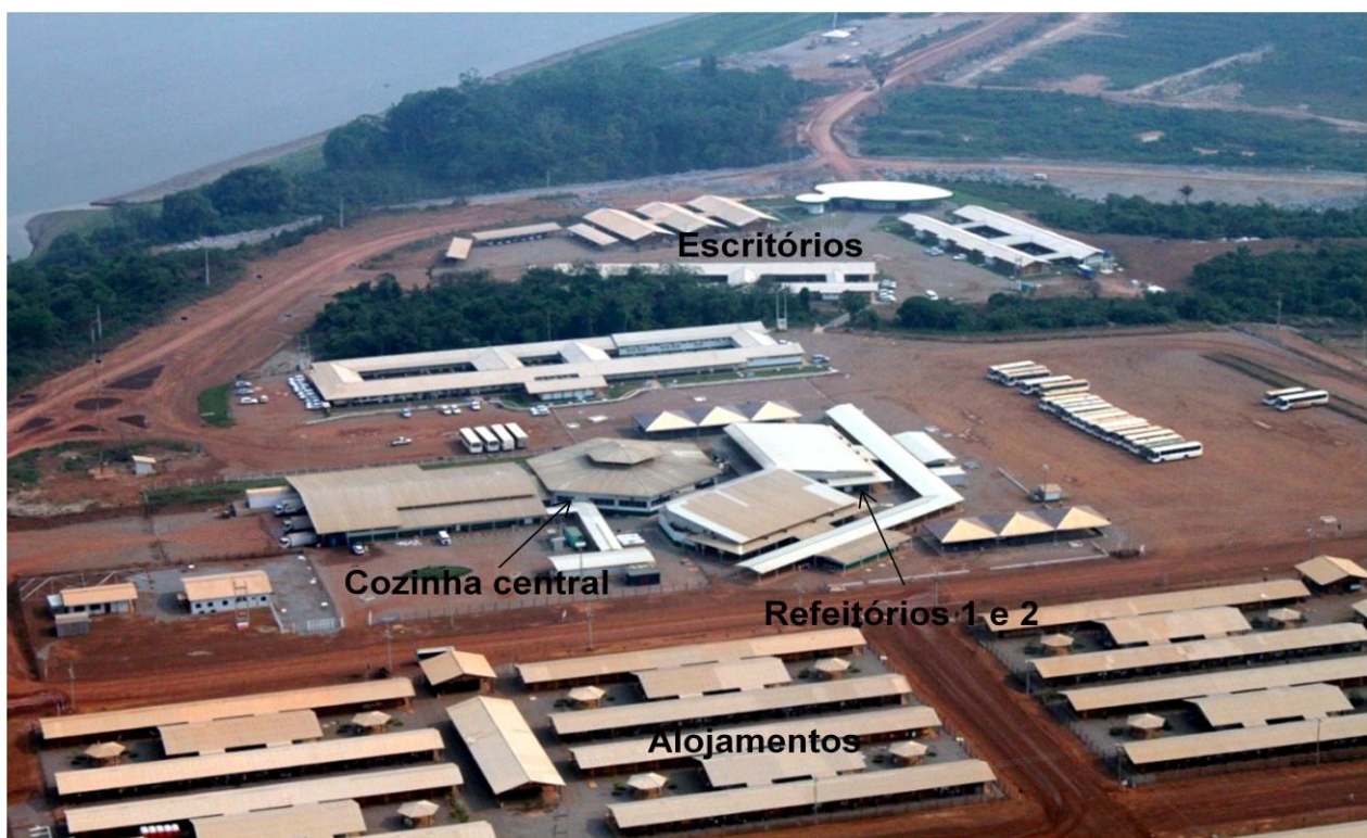
Figura nº 32. 15/09/2010 – Canteiro de apoio ME
