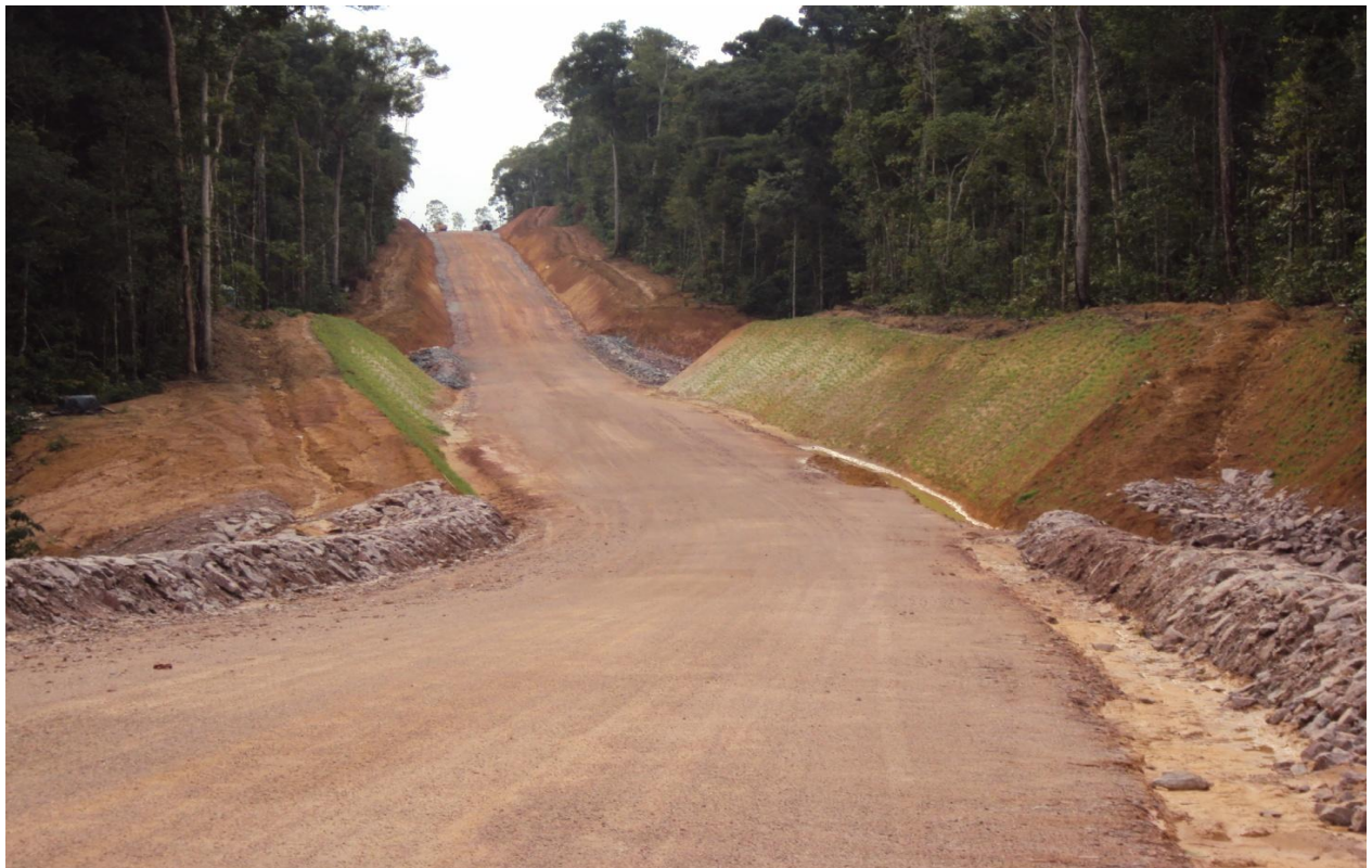
Figura nº 30. 07/12/2010 – Instalação de proteção de crista no aterro do acesso, conformação de drenagem e plantio de taludes
