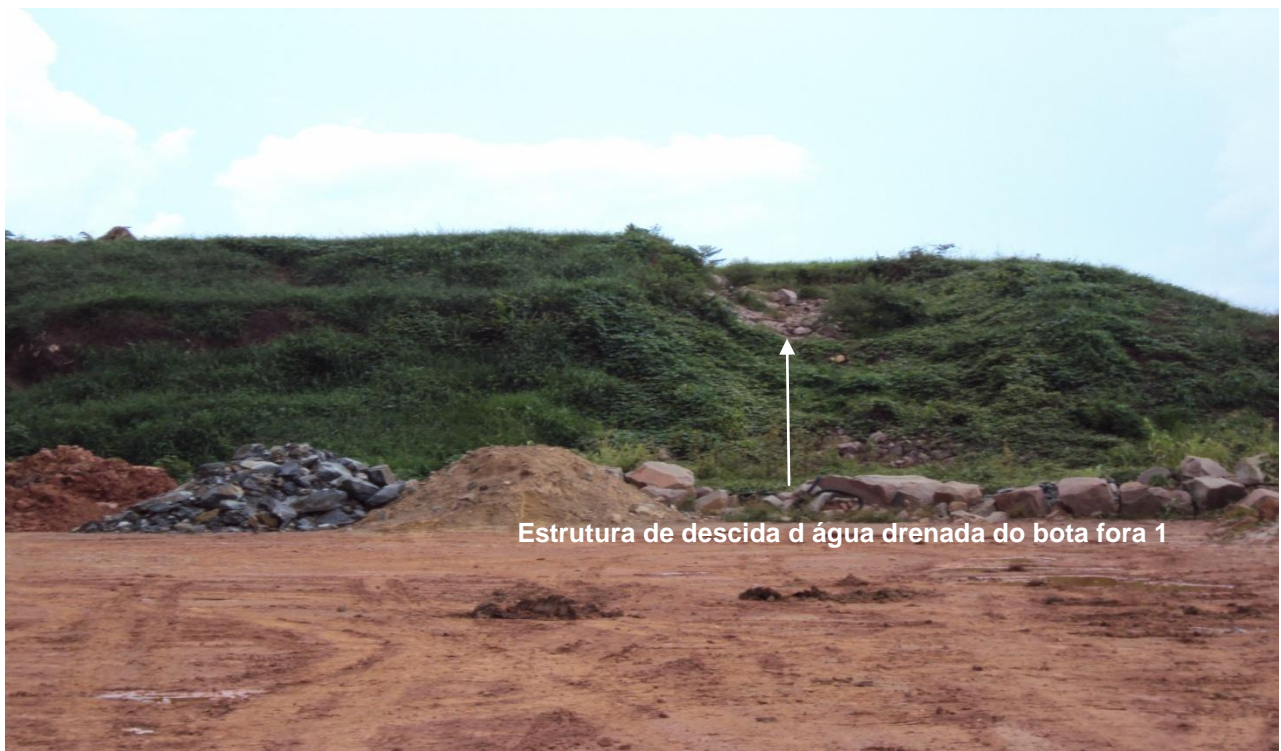
Figura nº 24. 07/10/2010 - Cobertura vegetal, estrutura de drenagem e conservação de solo do Bota Fora 1 –ME
