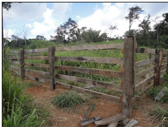
Figura 25. Construção de curral lote 33 do Sr. Marcio Camilo. Fonte: Emater - RO.
