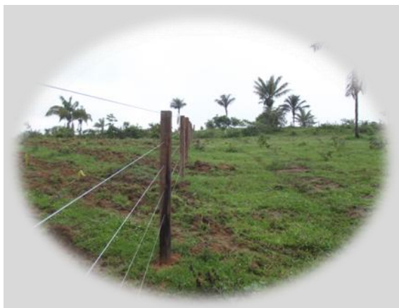
FOTO 28 – CONSTRUÇÃO DE CERCAS
