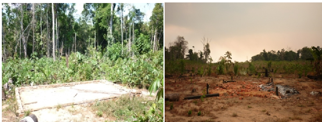
FIGURA 22. 4: Demolição de imóveis na área do reservatório
