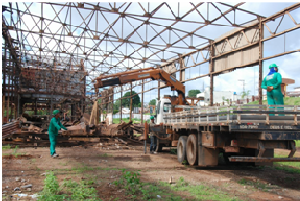
FOTO 21. 1: Retirada das telhas da área das oficinas
