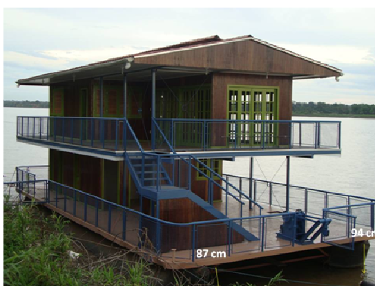
FOTO 10. 10: Vista frontal da Balsa-laboratório de limnologia ancorada no canteiro de obras, a montante da UHE Santo Antônio
