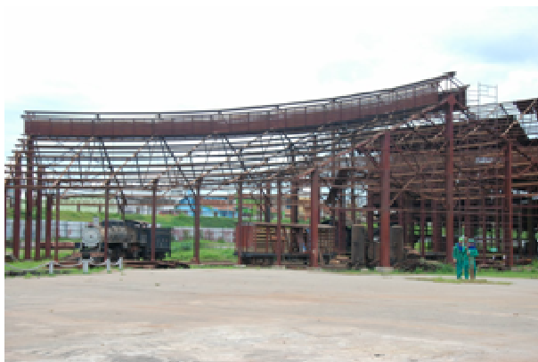
FOTO 21. 2: Retirada das telhas da rotunda
