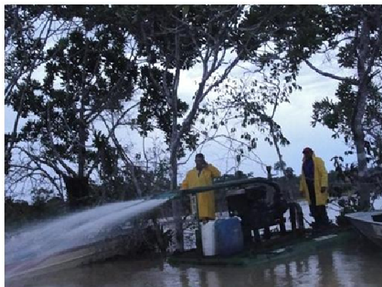
FOTO 10. 12: Bomba operando no igarapé Jatuarana I. Foto tirada em 26/12/2011
