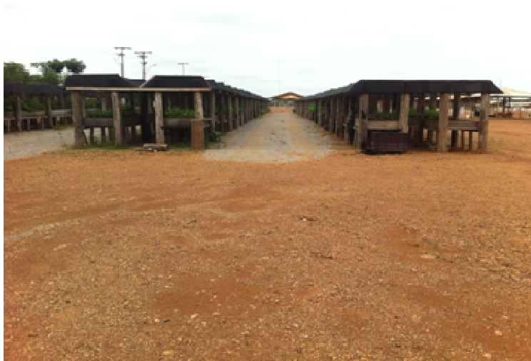
FIGURA2. 8: Viveiro de mudas – margem esquerda do canteiro de obras
