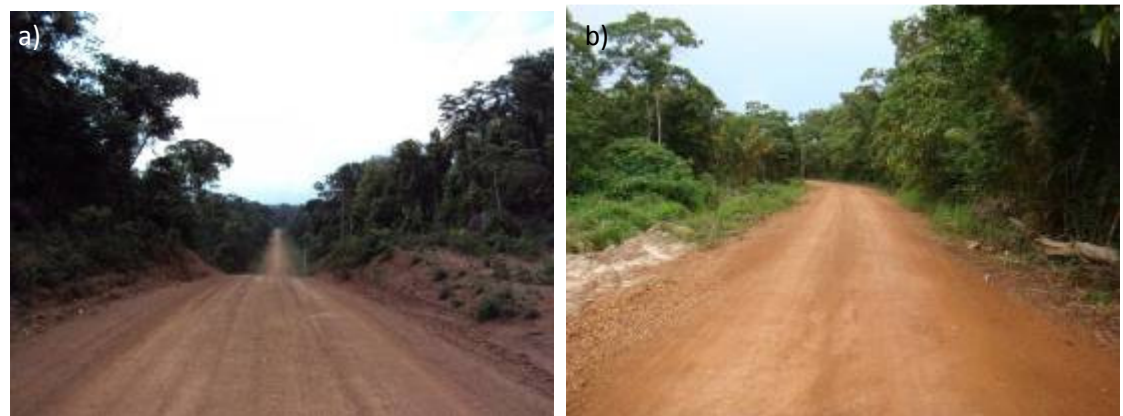
FIGURA 15: a) Implantação da PVH 13 – Margem Direita; b) Melhoria da PVH 10 – Margem Direita
