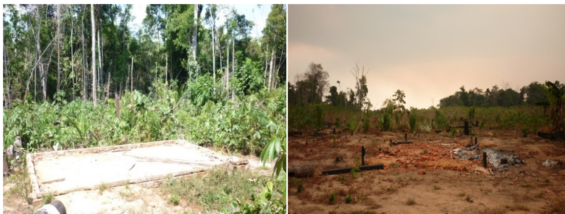
FIGURA 3: Demolição de imóveis na área do reservatório.
