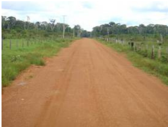
FIGURA 6: Melhoria da PVH-05 existente – Margem Esquerda
