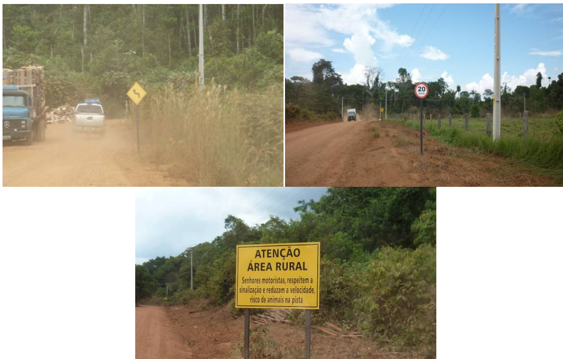
FIGURA 24: Placas de advertência no Ramal Teotônio para maior segurança dos usuários após a mudança do trajeto. (dez/2011)
