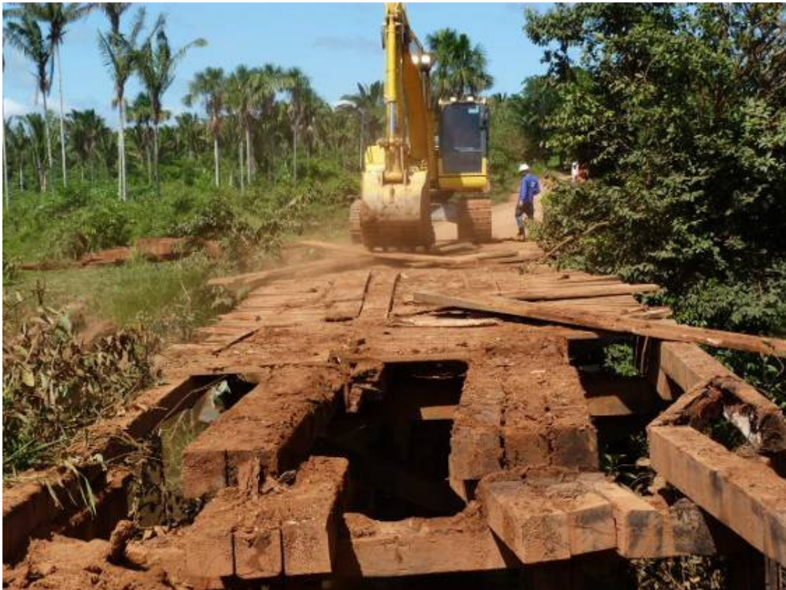
FIGURA 17: Remoção da ponte sobre o igarapé Jatuarana. (nov/2011).
