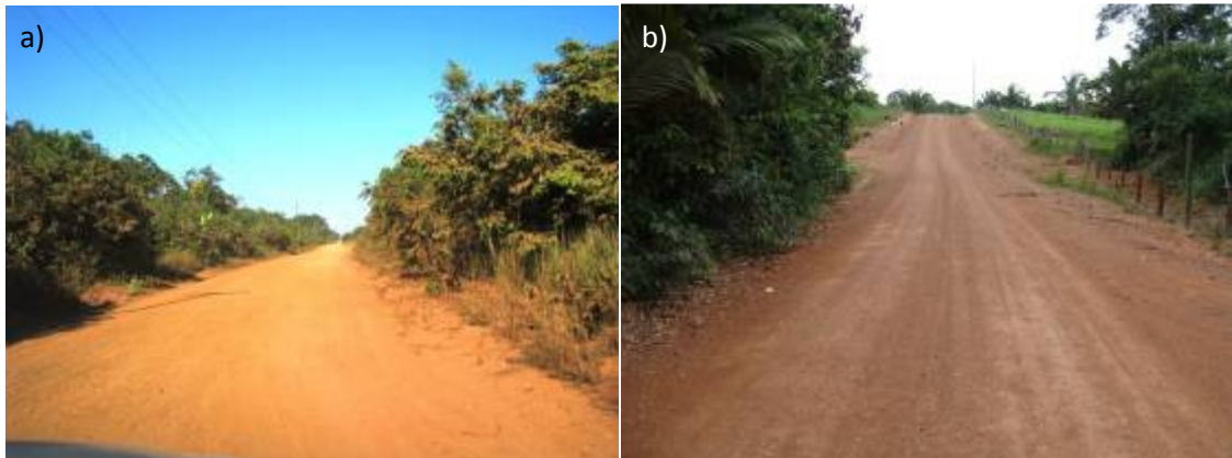
FIGURA 14: a) Implantação da PVH 5 – Margem Direita; b) Melhoria da PVH 12 – Margem Direita
