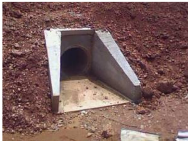
FIGURA 16: Galeria implantada nos locais necessários nas novas estradas vicinais.
