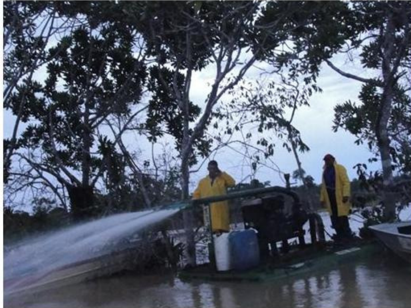
FIGURA 47: Bomba sendo operada no igarapé Jatuarana
