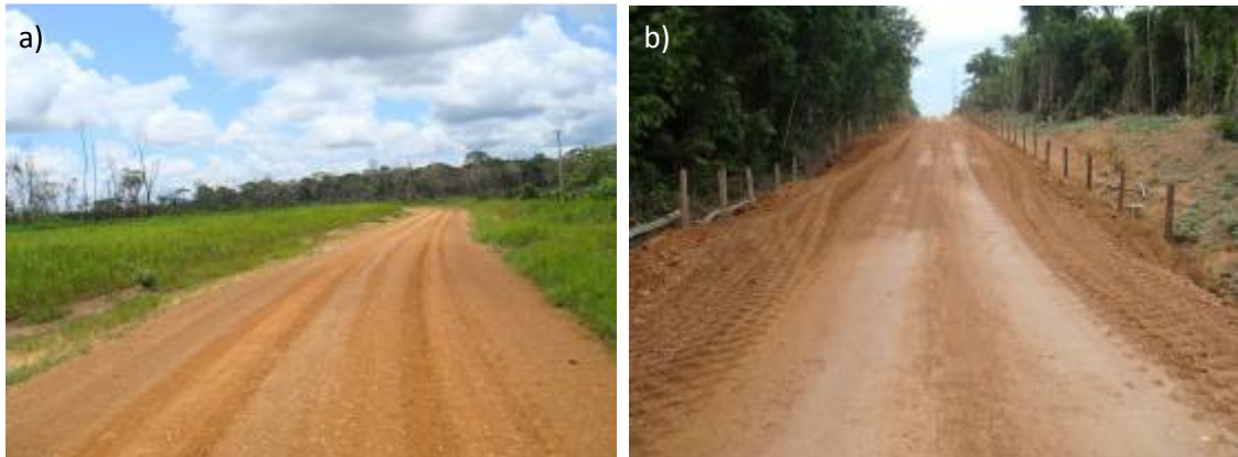
FIGURA 11: a) Melhoria do Ramal Porto Seguro – Margem Esquerda; b) Implantação do Ramal São Domingos e Riacho Azul– Margem Esquerda
