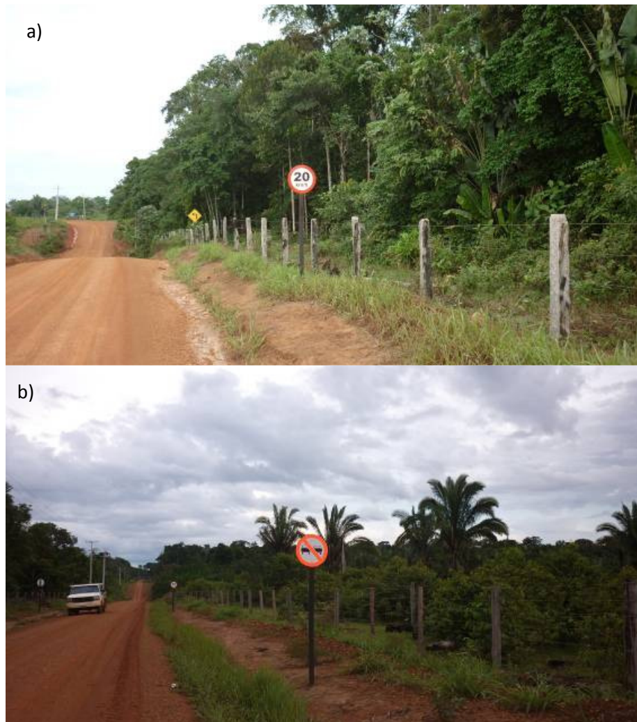
FIGURA 20: Trechos do novo acesso do Ramal Jatuarana já sinalizados com placas de advertência. a) Velocidade máxima; b) Proibida a ultrapassagem. (nov/2011).
