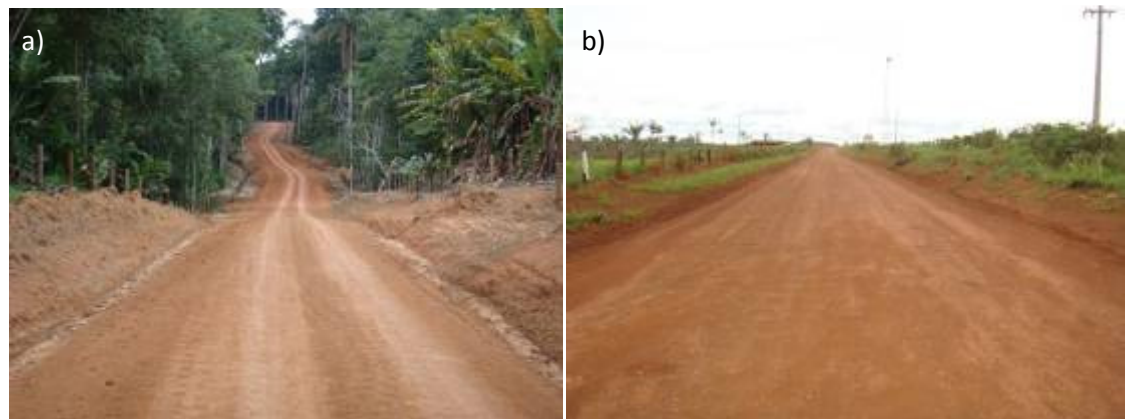
FIGURA 10: a) Implantação da PVH-08 B – Margem Esquerda; b) Melhoria do Ramal Jatuarana – Margem Esquerda
