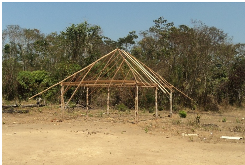
Foto 6-74 Estrutura de residência em construção. Aldeia Joari.
