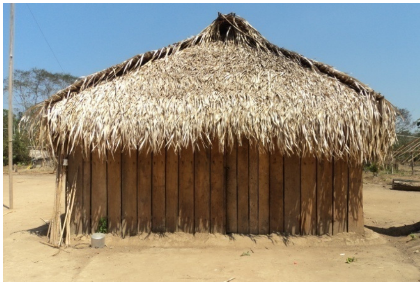
Foto 6-75 Residência com cobertura de palha e revestimento da parede com tábuas serradas. Aldeia Joari.
