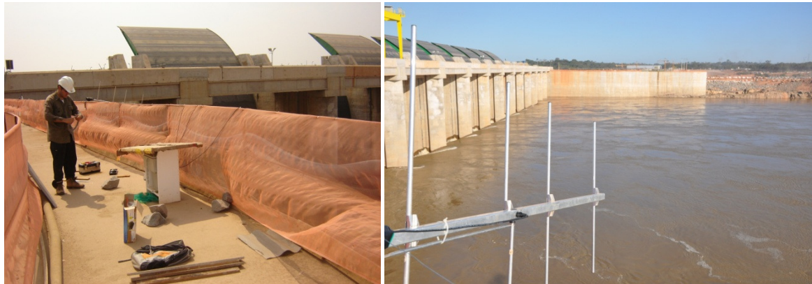
Figura 2. Base fixa (02) de radiotelemetria localizada na margem esquerda do rio Madeira a montante do VTP.
