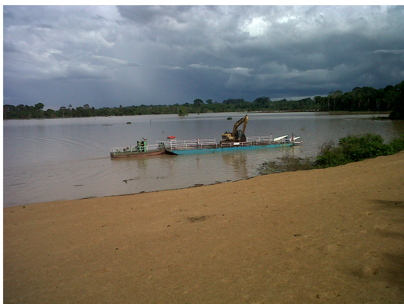
Foto 19 – Balsa com escavadeira hidráulica em operação
