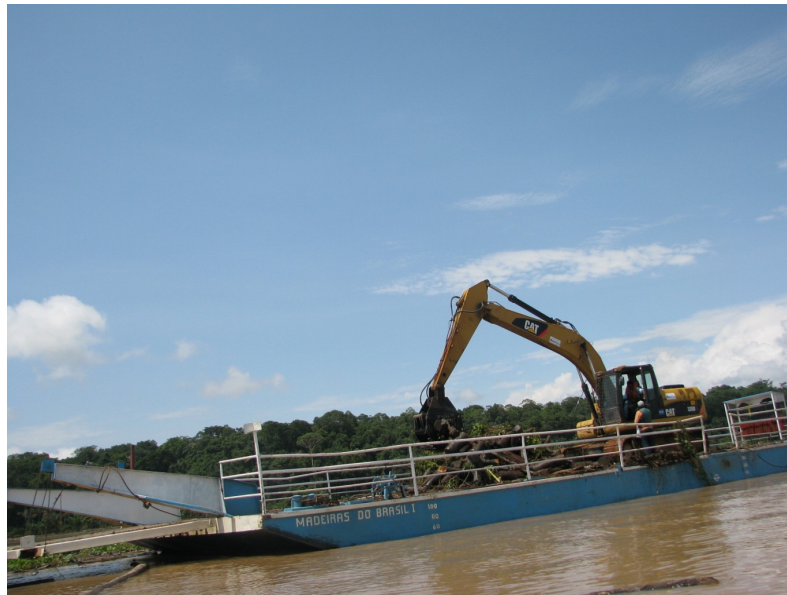
Foto 20 – Balsa com escavadeira hidráulica em operação
