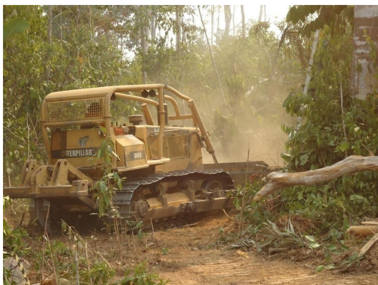
Foto 1 – Abertura de acesso na cota de alagamento.
