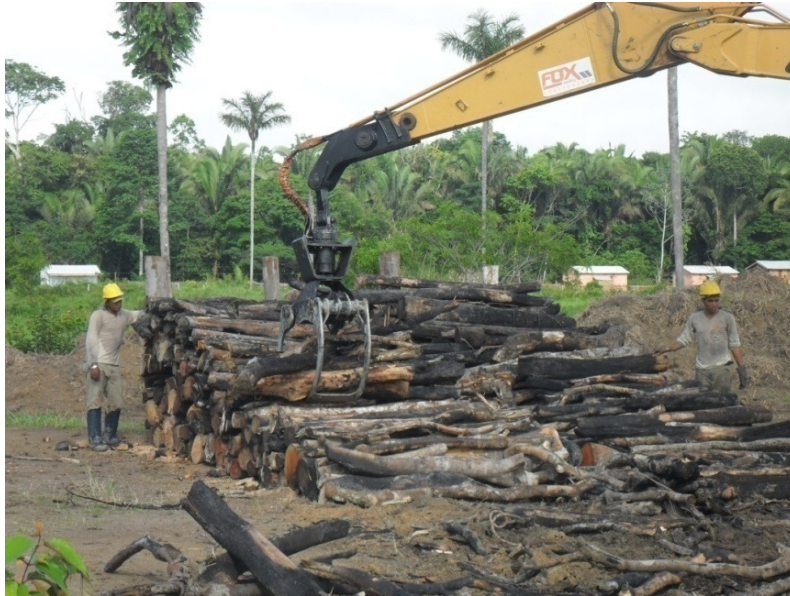
Foto 16 – Empilhamento mecanizado de lenha
